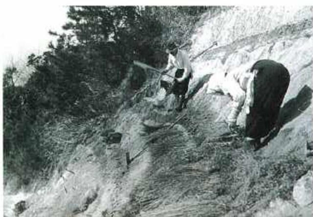
①水平階段を切りつけ、水平階段上に苗木植栽のための鉢床をつくるため、土で芝を固める
