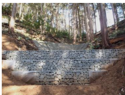
人家裏山の簡易防災施設の設置 (鋼製かご枠工)
