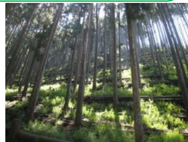
土留工の設置により表面侵食防止機能が向上
