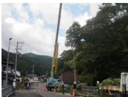
クレーンを用いた人家裏の危険木伐採
