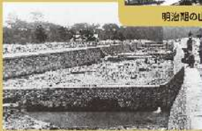
明治28年 逆瀬川における砂防工事(宝塚市)
