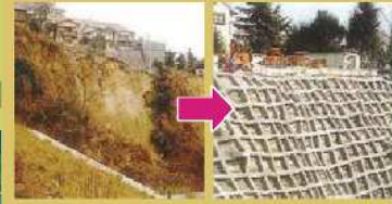
杉谷山腰工(阪神淡路大震災・災害関連緊急砂防事業)
