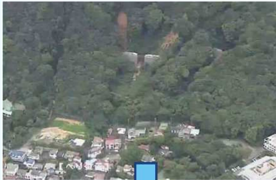
三の谷1号堰堤(三の谷川)
