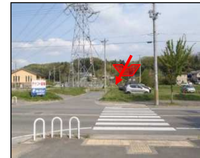
工事中 (掘削完了)
