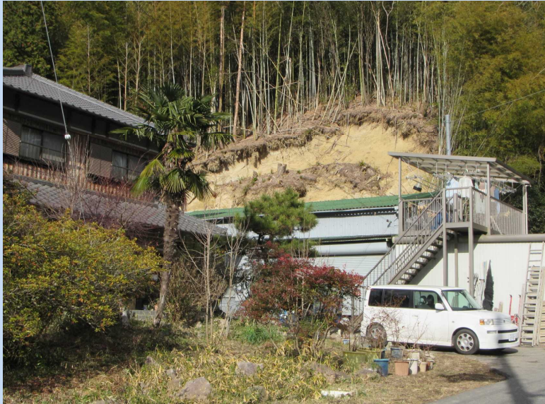
①山腹崩壊発生状況(平成30年7月)
