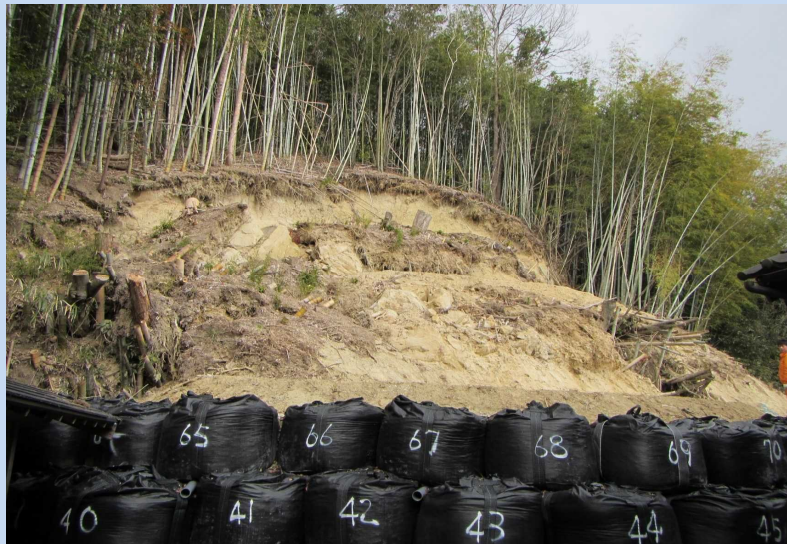
②応急工事の状況(平成30年11月)
