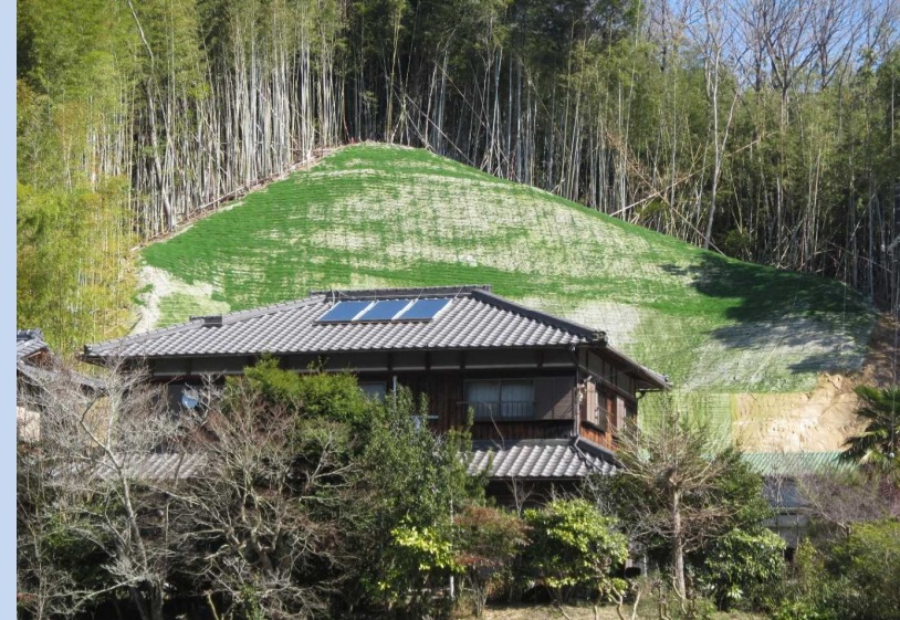
③復旧工事の状況(令和2年3月)
