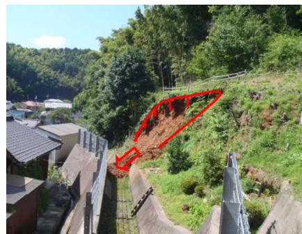
待ち受け擁壁が崩壊土砂を捕捉（丹波市）
