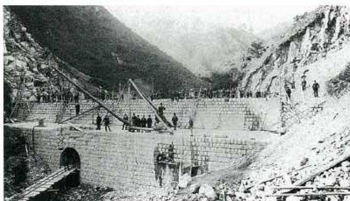
▲神戸で最初の水源地・布引貯水池の堰堤工事(明治33年完成)
