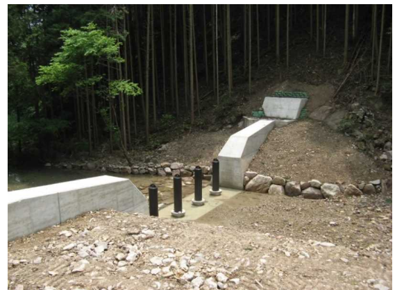
透過型治山ダム(鋼製スリット+コンクリート) (流木捕捉式ダム)
