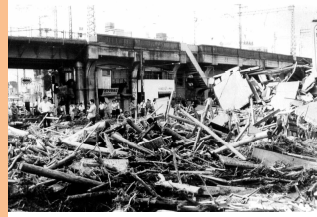
神戸駅付近の惨状 (神戸市中央区)
