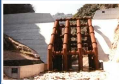
平成5年格子型スリットダム
