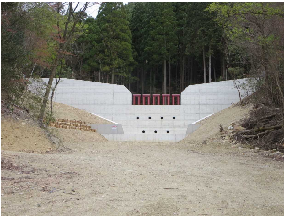
ひょうご式治山ダム(鋼製スリット+コンクリート)
