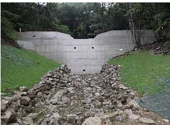
不透過型治山ダム(コンクリート)
