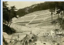
昭和13年 災害復旧工事
