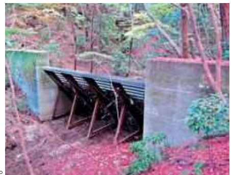
写真-7 昭和44年施工のスリット式治山ダム(六甲治山事務所提供)
