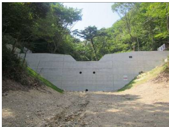
不透過型治山ダム（コンクリート）
