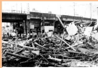
神戸駅付近の惨状（神戸市中央区）
