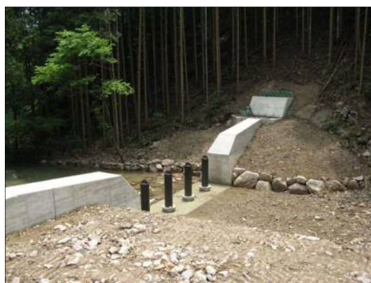
透過型治山ダム（鋼製スリット＋コンクリート） （流木捕捉式ダム）
