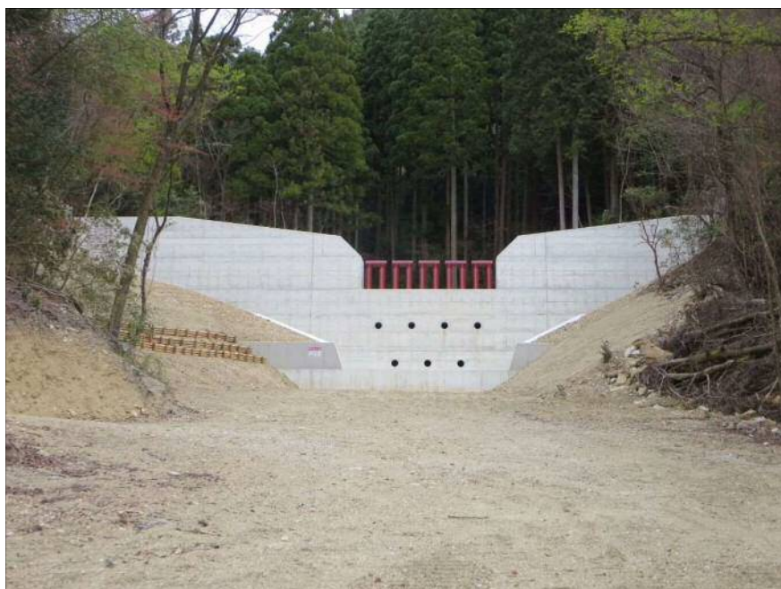
ひょうご式治山ダム（鋼製スリット＋コンクリート）
