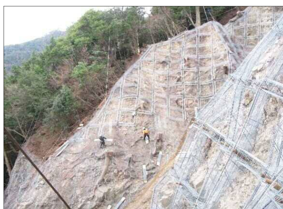
工事施工中（法枠工）
