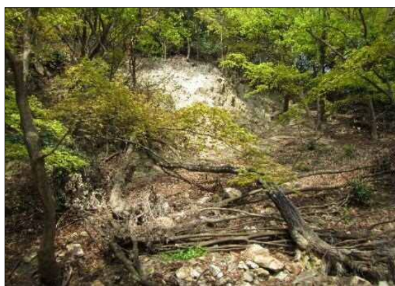
山腹崩壊状況
