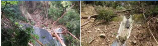
平成26年台風11号災害では、谷止工や土留工が崩壊土砂及び流木を捕捉(神戸市北区、神戸市灘区)
