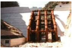
平成5年格子型スリットダム
