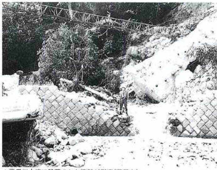
▲芦屋川中流に設置された擁壁が倒壊(芦屋市)
