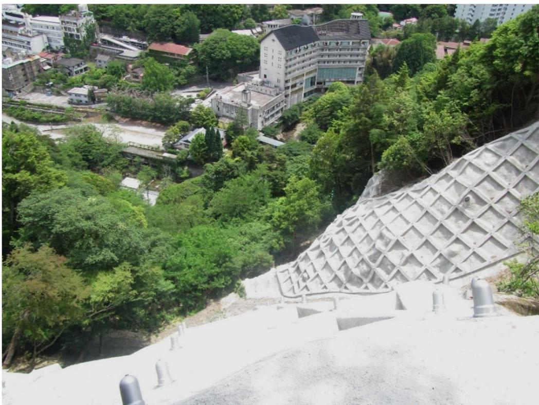
法枠工と鉄筋挿入工を施工
