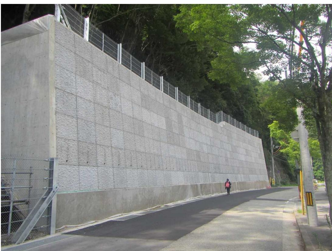
プレキャストコンクリートパネルを連結し、その背面に気泡混合
