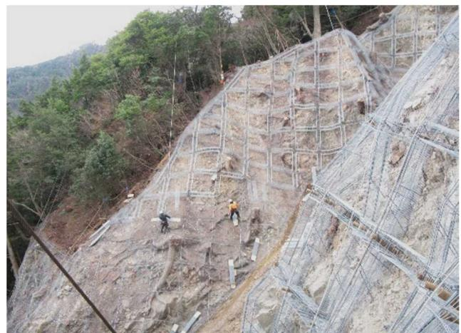
命綱を着用して法枠工を施工
