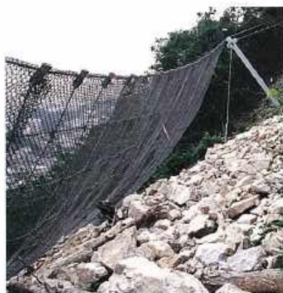
▲応急工事のカーテン式ロックネット工
