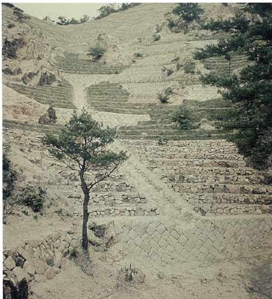
▲石積工、石筋工、石張水路工、段積工、四枚積苗工
