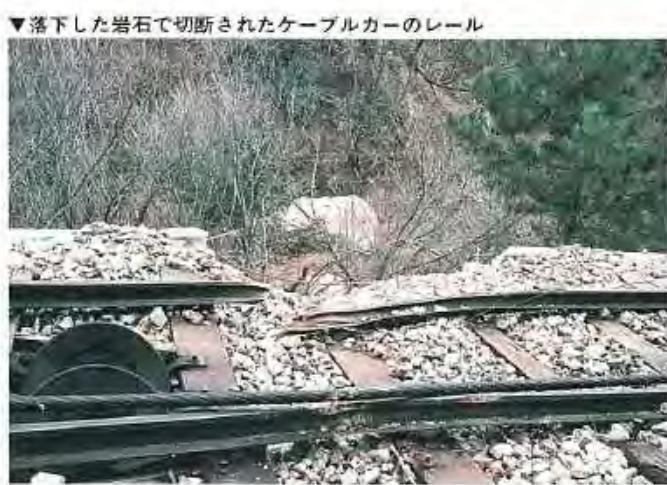
▼ 落下した岩石で切断されたケーブルカーのレール
