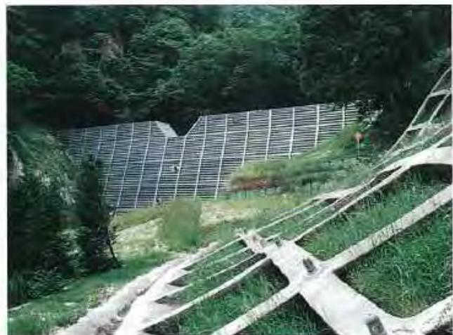
▲中地区No.2 谷止工、法枠工完了
