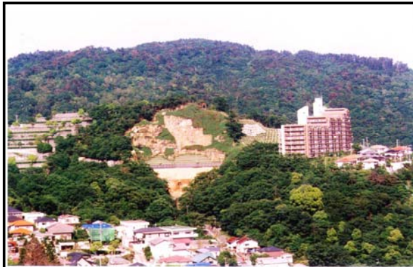
工事完成直後
