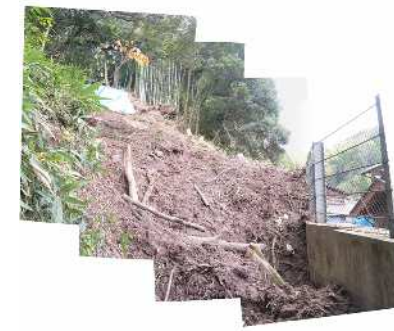
待ち受け擁壁が崩壊土砂を捕捉（豊岡市）
