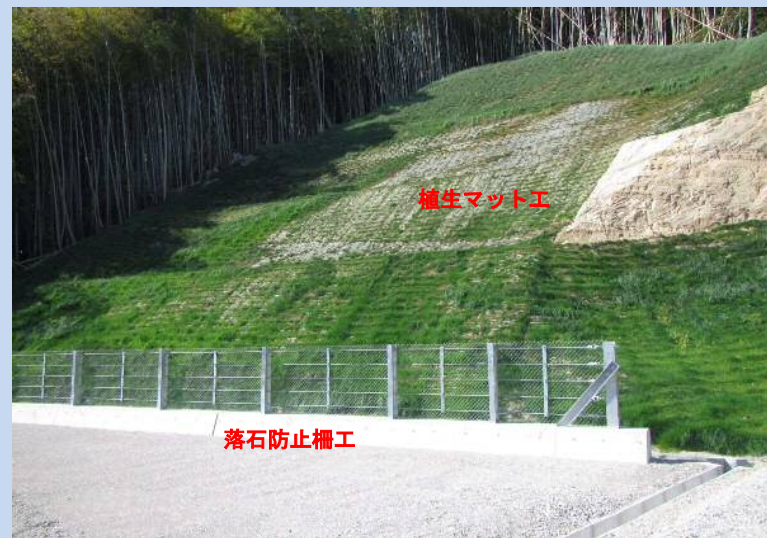
③復旧工事の状況(令和2年5月)
