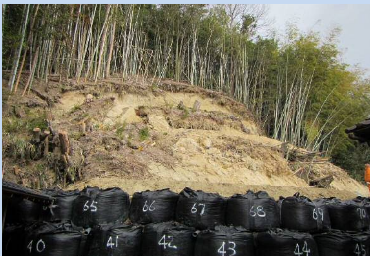
②応急工事の状況(平成30年11月)
