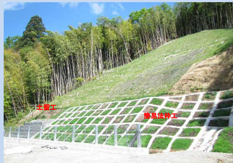
④復旧工事完了の状況(令和3年5月)
