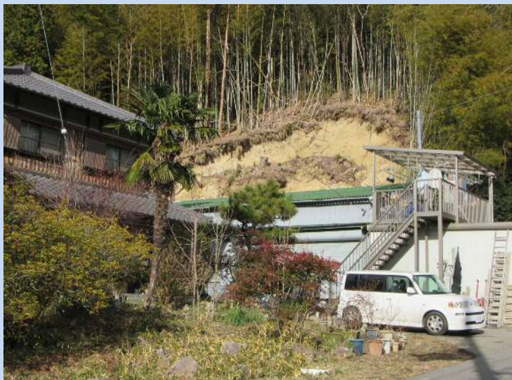
①山腹崩壊発生状況(平成30年7月)
