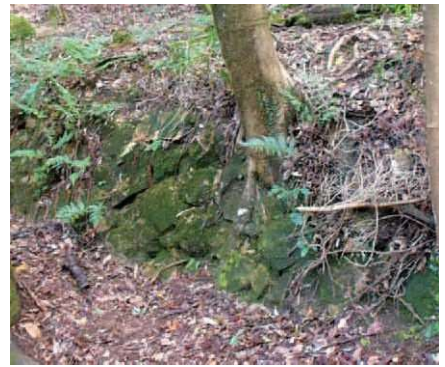
写真-2 現存している谷留石堰堤。写真-1に写っているものと思われる。
