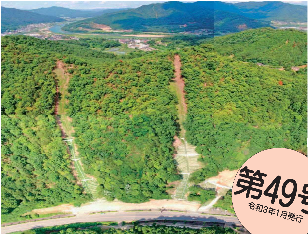
平成30年度 災害関連緊急治山事業（養父市八鹿町朝倉 地内） 完成3箇月後
