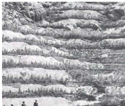
写真-1 試験植林で施工された積苗工や谷留石堰堤
