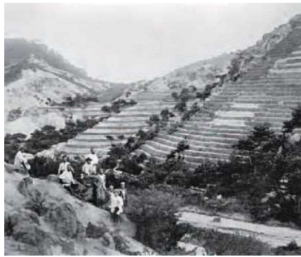
写真-3 砂防工事の施工直後。写っている人のうち一人は林業巡回教師と考えられる。
