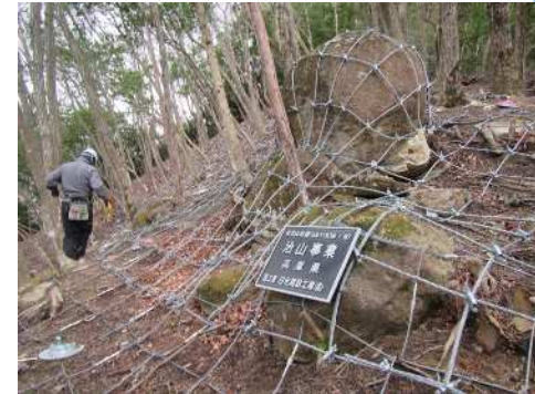
ロープネット・ロックボルト併用工法の概要
