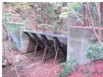
S44年施工のスリット式治山ダム
