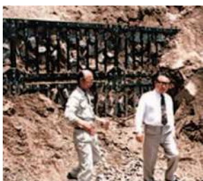
谷大臣に鋼製土留工を説明 (平成7年当時)
