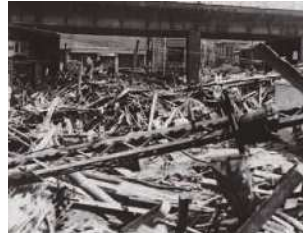
昭和13年災害の被災状況
