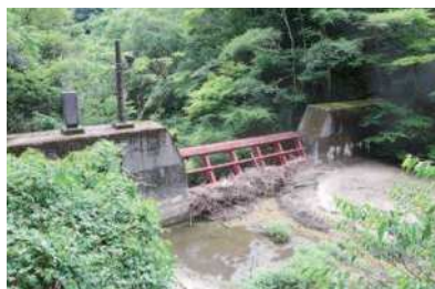
S46 諏訪山第二砂防ダム
