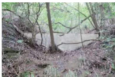
S43 治山事業山腹工
