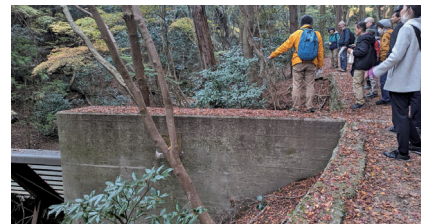
職員による治山構造物の説明
