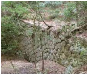
④ 古い石積堰堤
