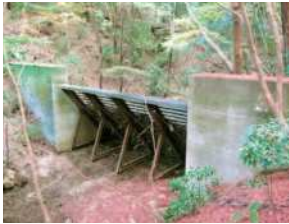
④-2 昭和44年施工のスリット式治山ダム
