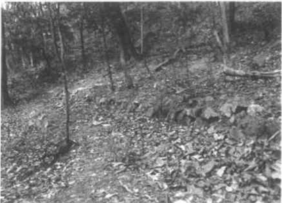
5-1. 再度山永久植生保存地 (埋没した山腹積苗工石垣)
