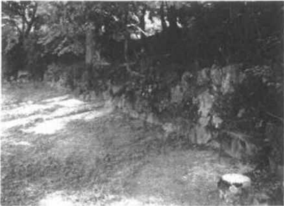
2-1. 修法ヶ原池池堤 (池堤石垣・護岸)
