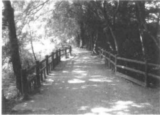
2-1. 修法ヶ原池池堤 (堤上部の園路)
