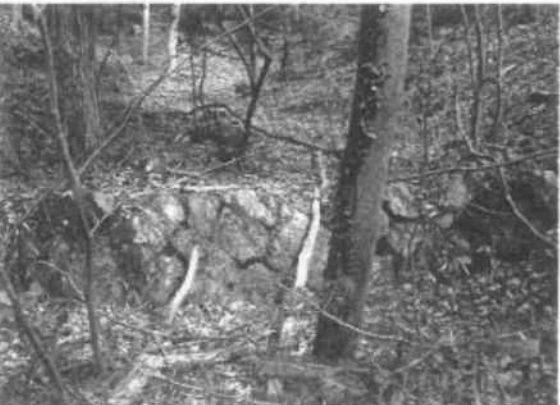
5-1. 再度山永久植生保存地 (山腹積苗工石垣)
