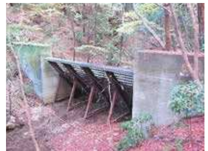
S44年施工のスリット式治山ダム
