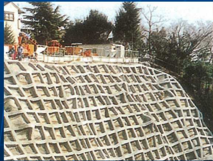
杉谷山腹緊急工事 完成
