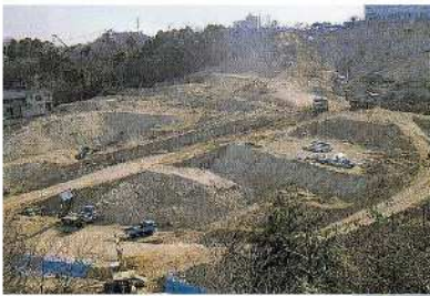
地すべりによって崩れた土砂の除去作業（平成7年2月）
