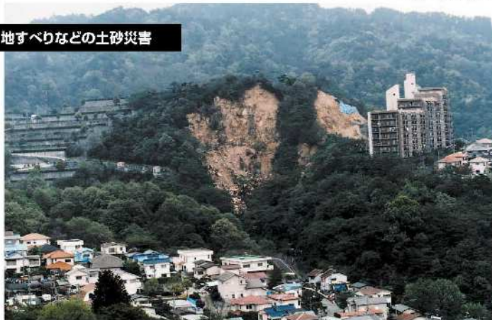
住吉台の山腹崩壊
