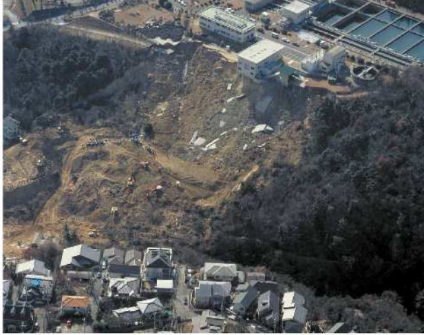
仁川・百合野地区で発生した地すべり災害
