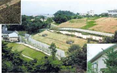
復旧工事の完了した仁川百合野地区。左側のグリーンの障物が斜面の動きを自動監視するシステムを持つ「地すべり資料館」（平成9年7月）
