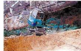
ロッククライミングマシンによる急傾斜の石や泥の除去作業
