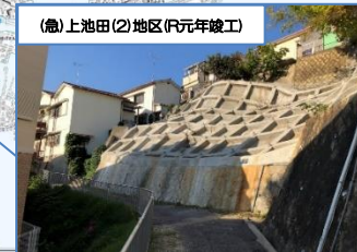
(急)上池田(2)地区(R元年竣工)
