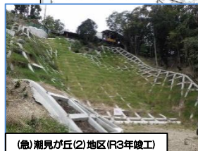
(急)潮見が丘(2)地区(R3年竣工)
