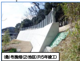
(急)布施畑(2)地区(R5年竣工)
