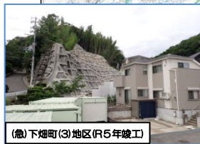
(急)下畑町(3)地区(R5年竣工)
