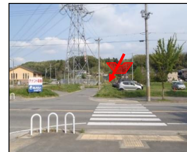
工事中 (掘削完了)
