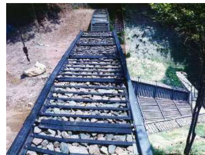
復旧後 平成12年（2000年）4月
