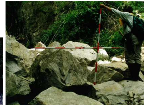
崩壊土石の堆積状況
