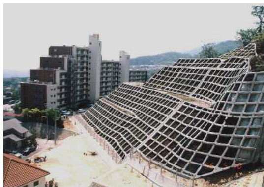
工事完成直後
