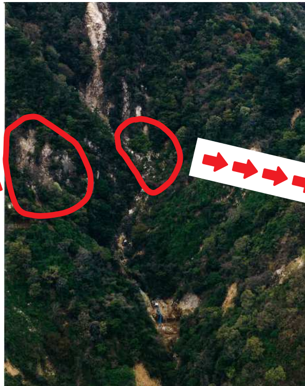
工事施工中 平成8年（1996年）3月
