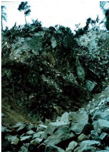
上流部の山腹崩壊状況
