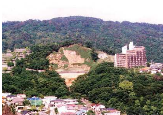
工事完成直後
