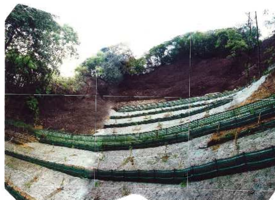
復旧後 平成 8 年 (1996 年) 4 月
