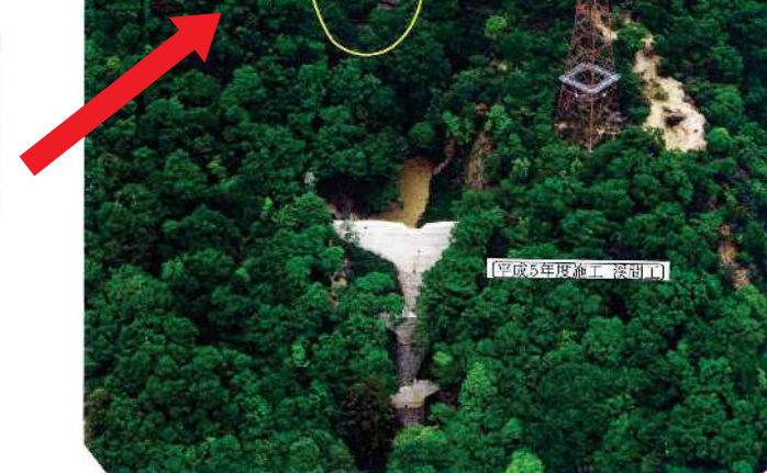
復旧状況 平成 8 年 (1996 年) 4 月
