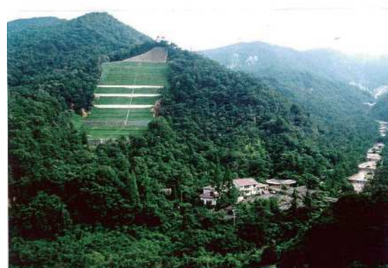
工事完成直後 平成9年（1997年）
