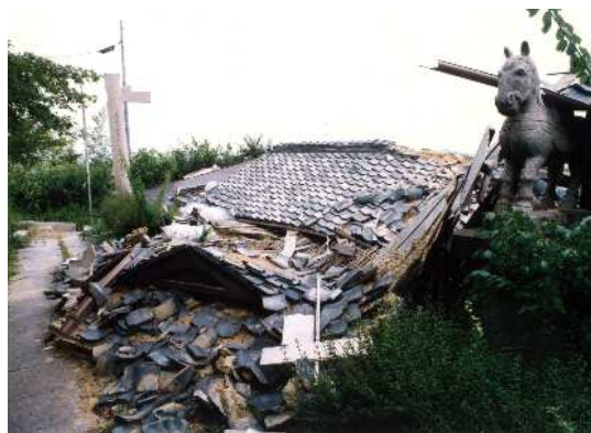
家屋全壊状況
