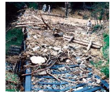
過去に施工していた治山ダムにより土砂を止め被害を最小限に食い止めた。
