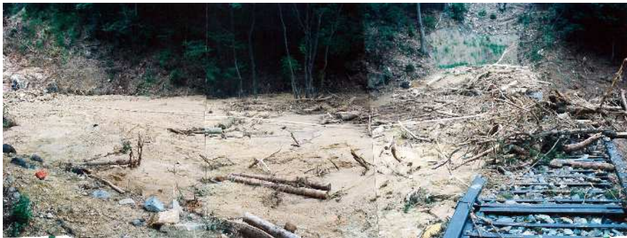
平成10年度施工した治山ダムで土石を止めた。
