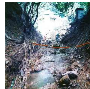
降雨水により過去に堆積していた土砂を押し流した。
