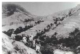
▲塩ヶ原（現在の修ヶ原）植林工事完成時（明治36年） （神戸市資料）
