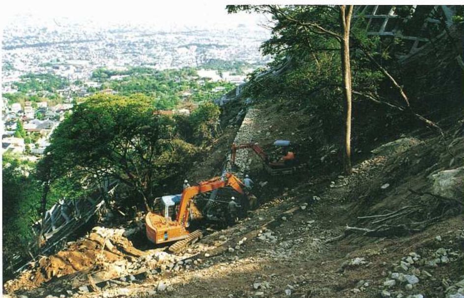
土留工施行中
