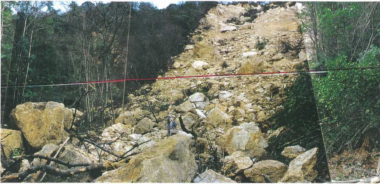
山腹崩壊状況
