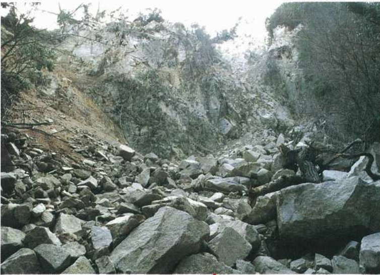
上流部の山腹崩壊
