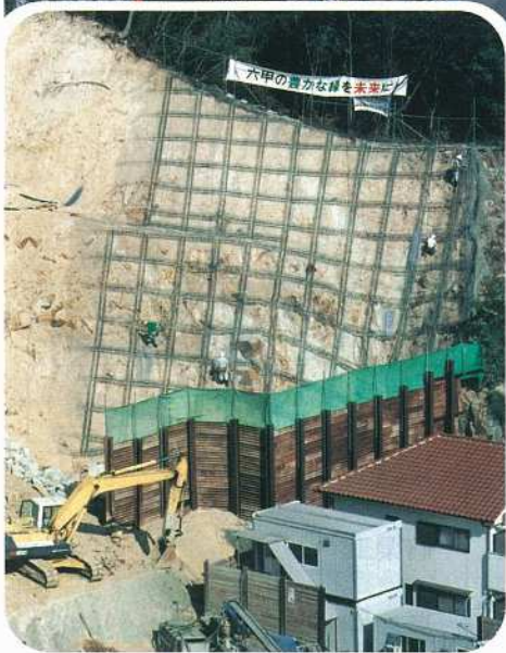
法切、法枠工施行状況
