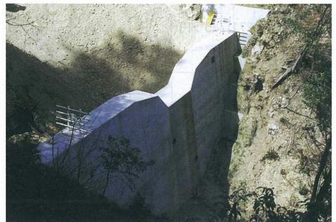
谷止工完了 (H8)
