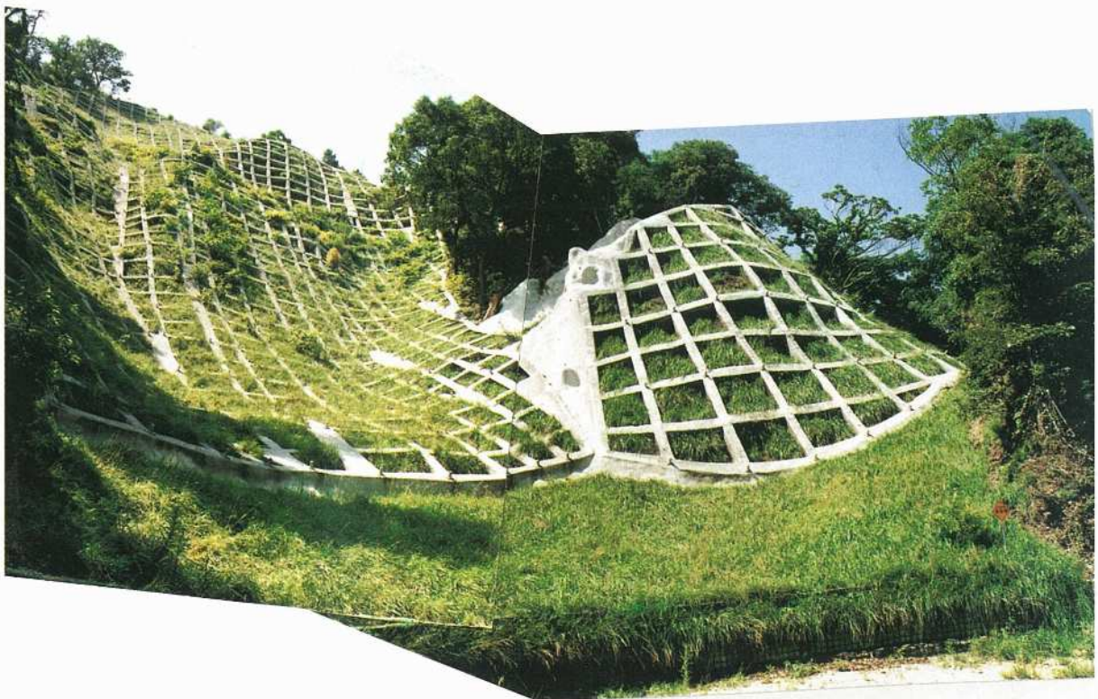
法枠工完了（中地区）
