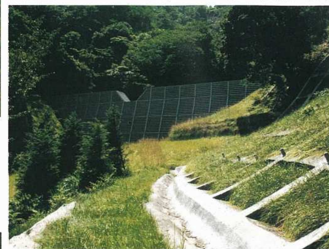
中地区 No.2 谷止工、法枠工完了
