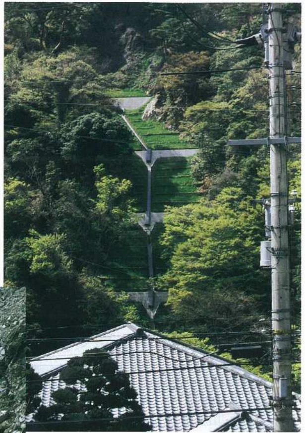
(北崩壊地) 工事完了状況
