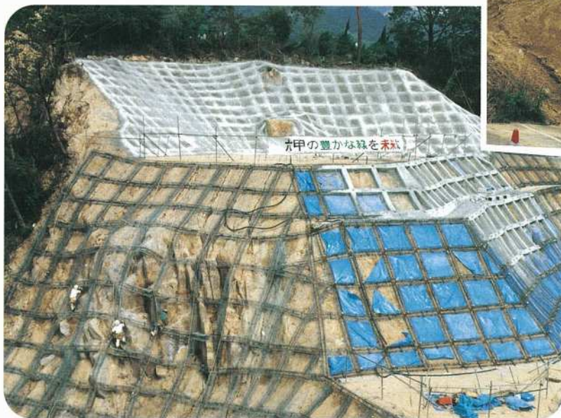
法枠工施行状況
