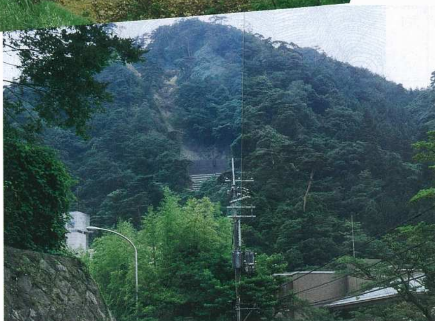
(南崩壊地) 施工地全景
