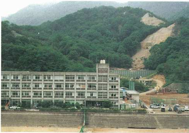
保全対策（学校）と谷止工、山腹工（施行中）
