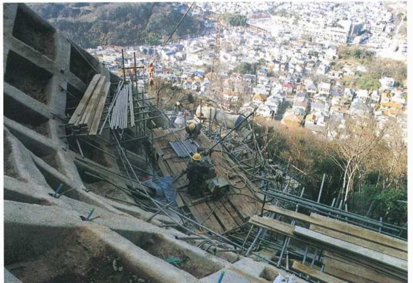
アンカー工 施行状況
