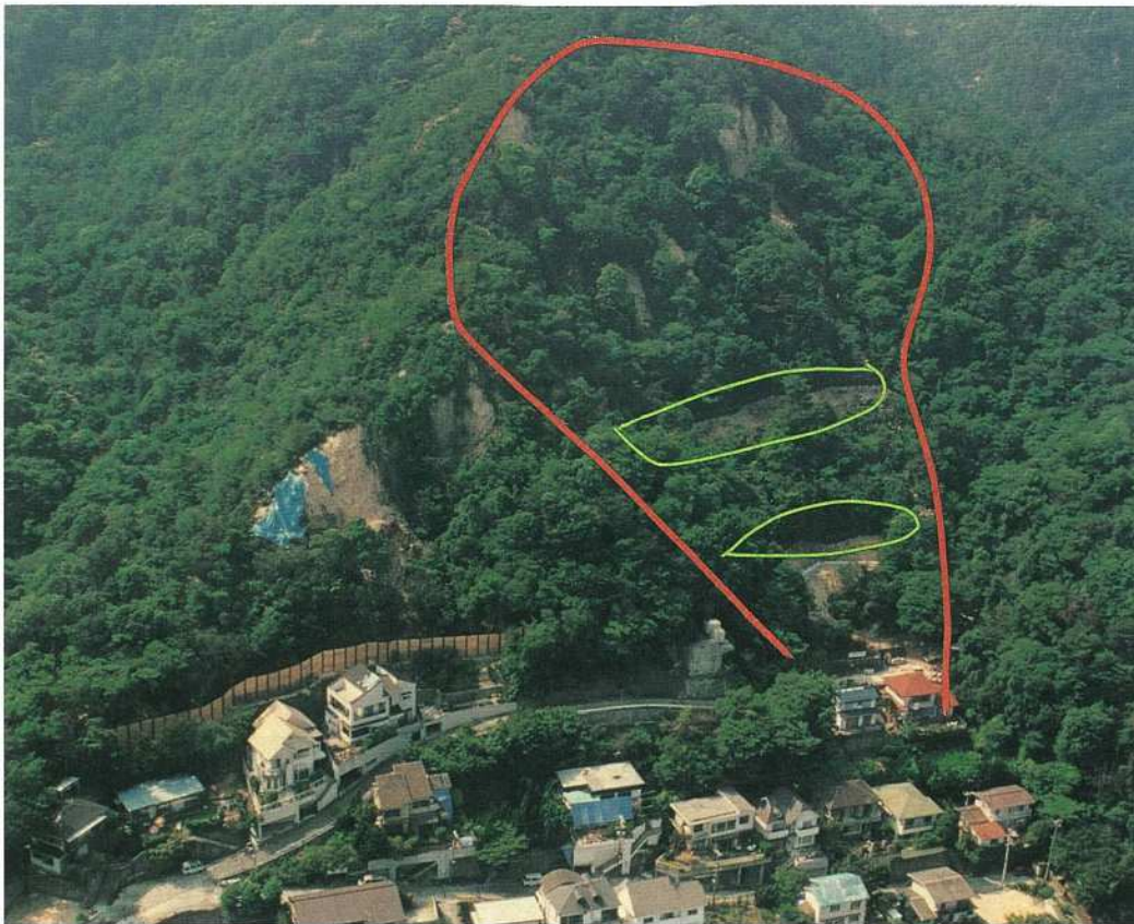
仮設工事完了 (H7.8.8)
