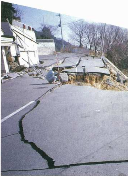
地すべりによる被害 (神戸市東灘区西岡本)
