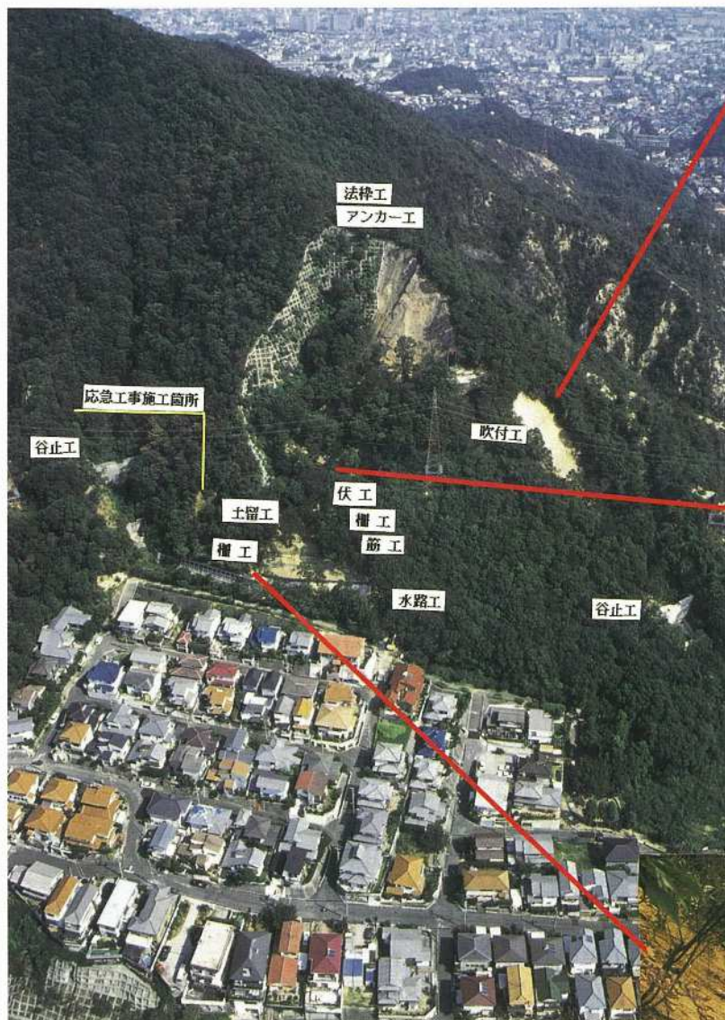
工事施行地全景 (H7.7.13)
