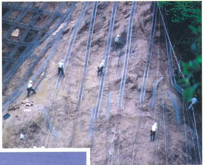
法枠工施行状況
