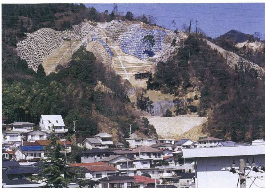
山腹工事施工中
