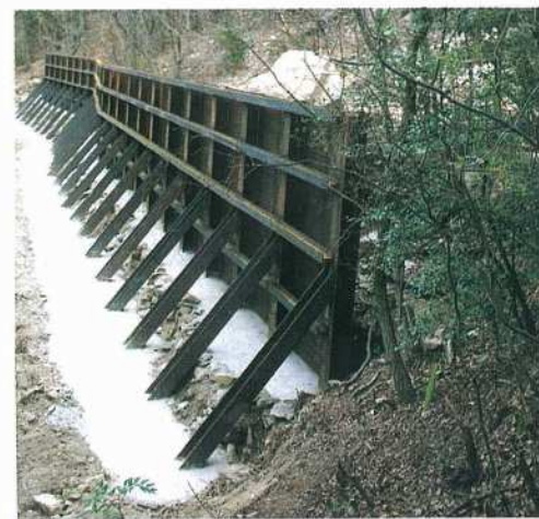
応急工事 仮設防護柵 (H7.3)
