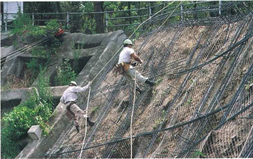
法枠工 組立状況
