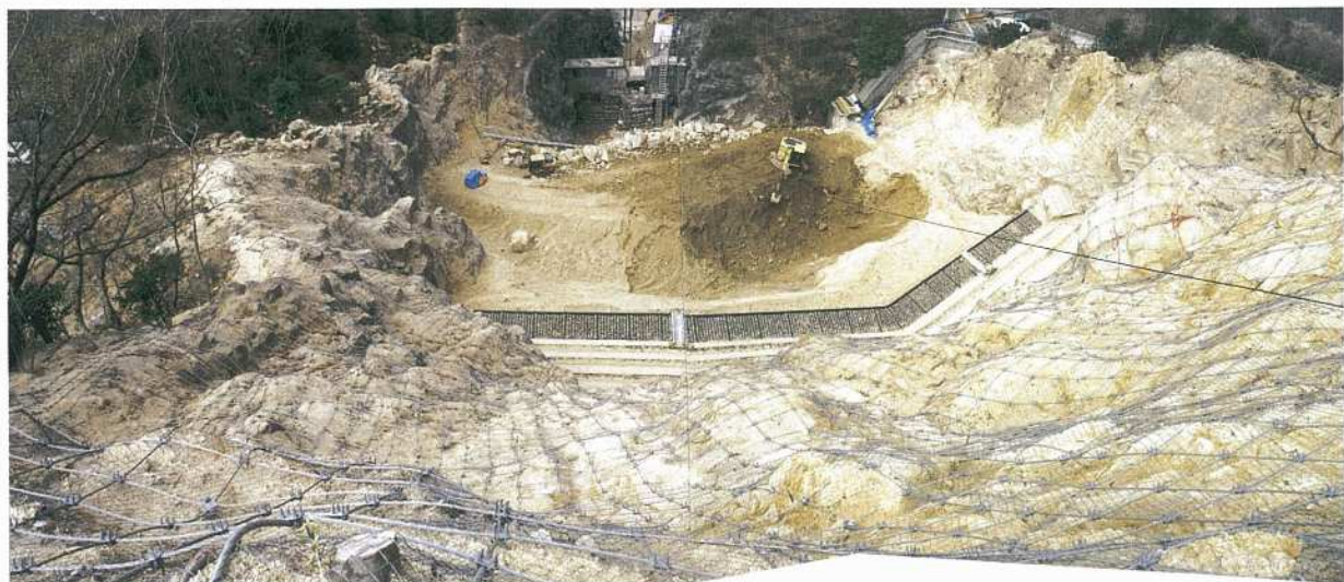
ロックネット工完了
