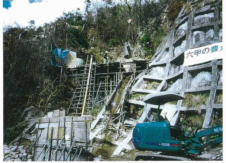
現場外残土処理（索道使用）
