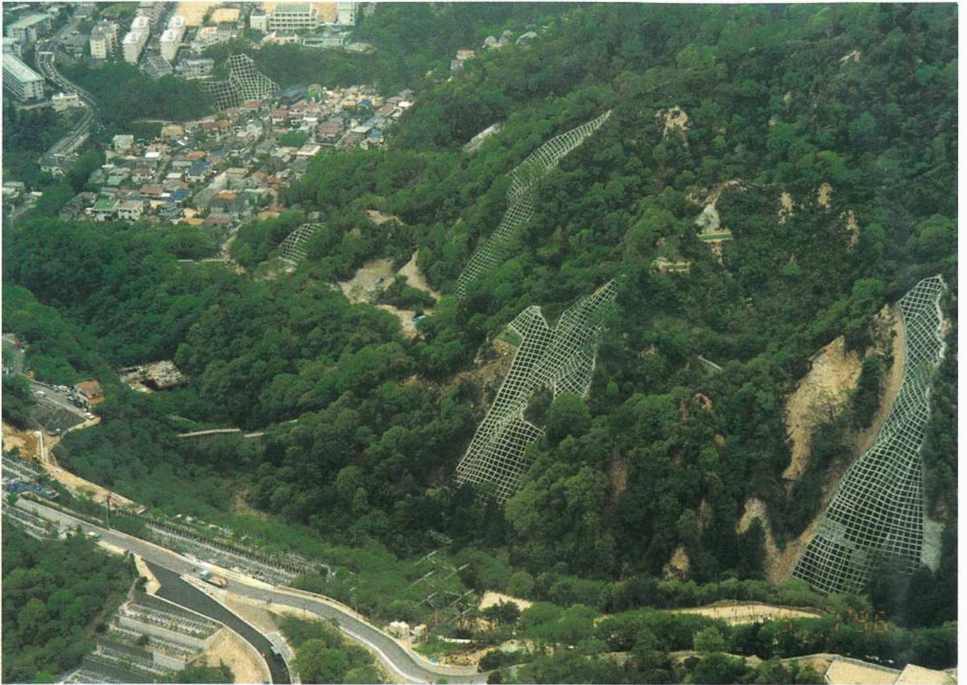
東地区工事完了状況
