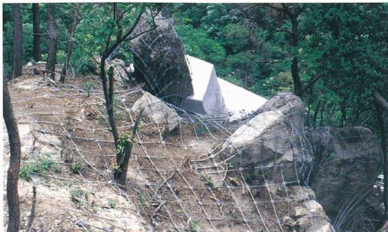
ロープネット工 根固工
