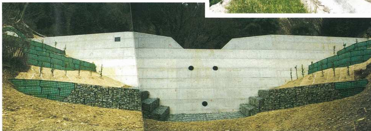
西地区 No.1 谷止工完了
