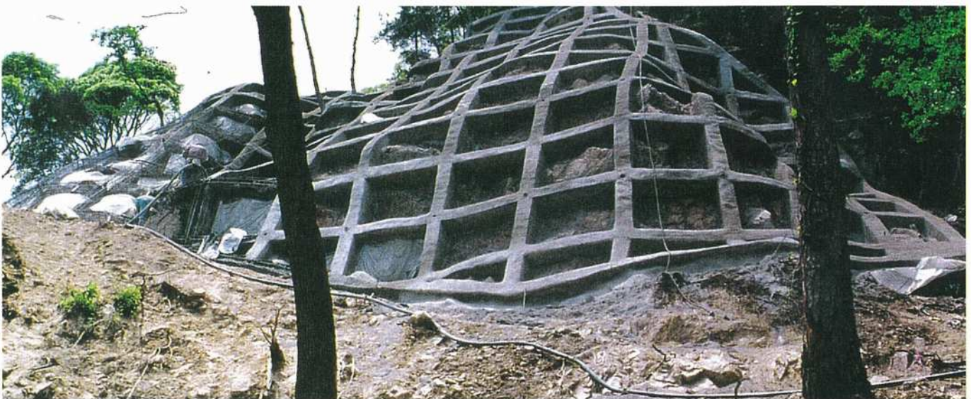
フレーム吹付施行中
