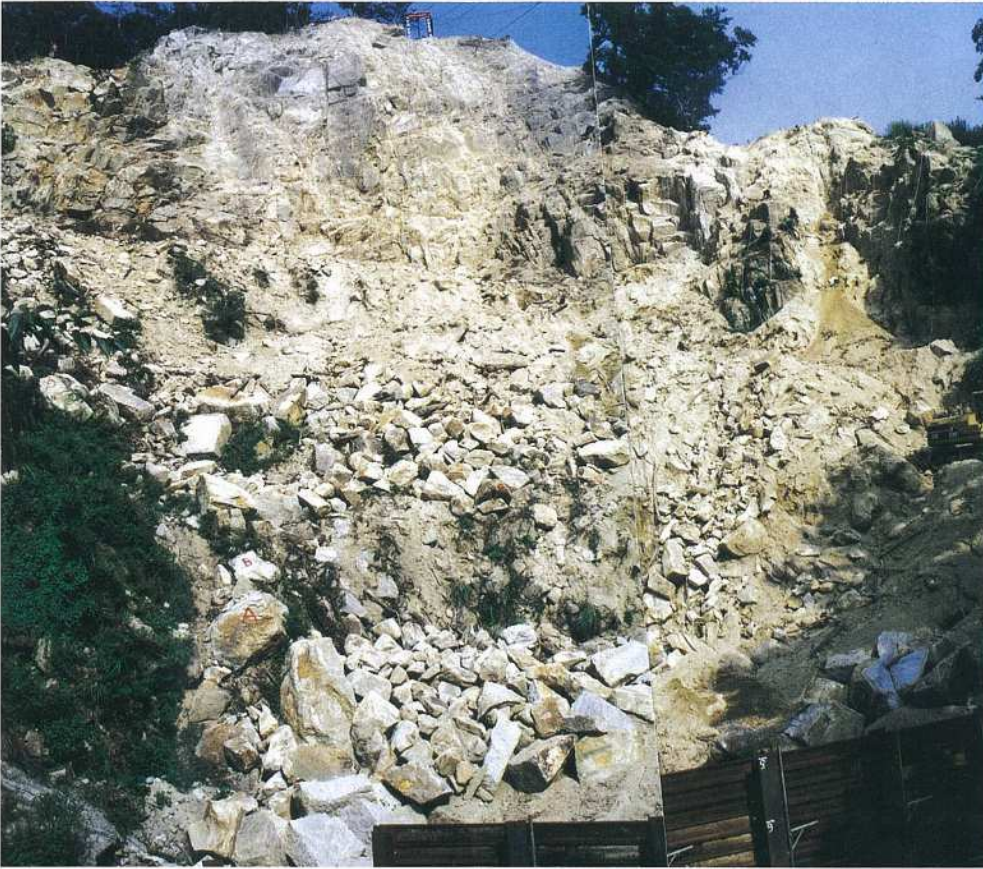
山腹崩壊の状況
