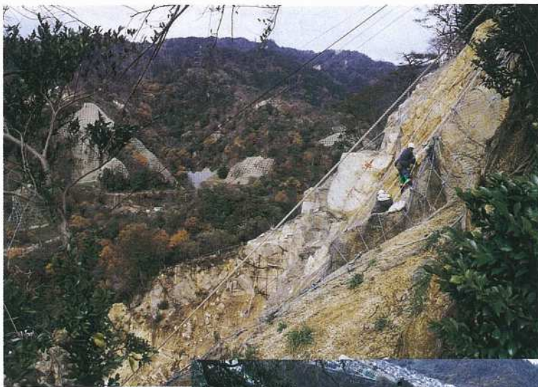
ロックネット施工状況
