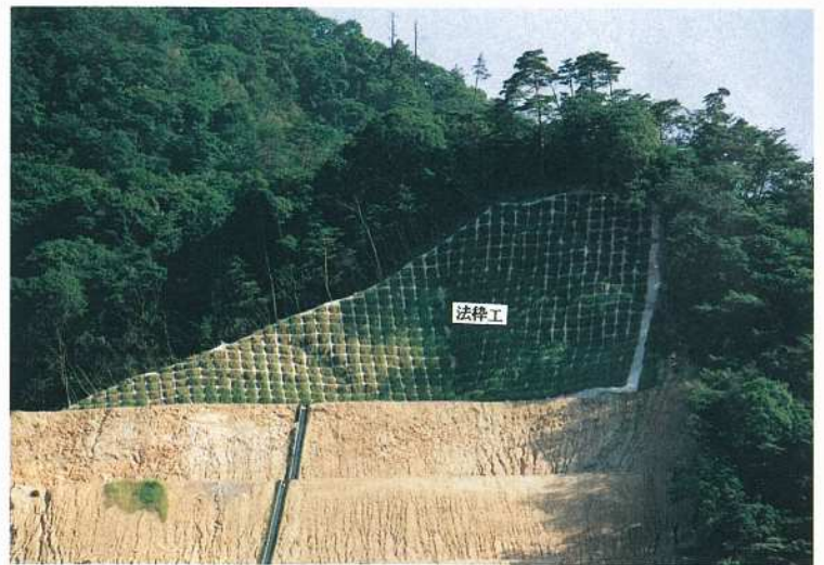
法枠工完了
