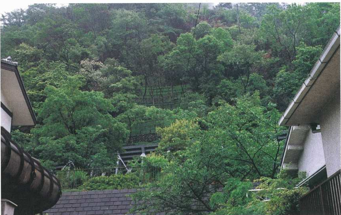
応急工事 完了 (H7.2.4~H7.3.20)
