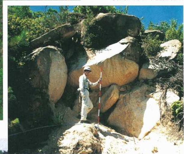
斜面上部の不安定転石
