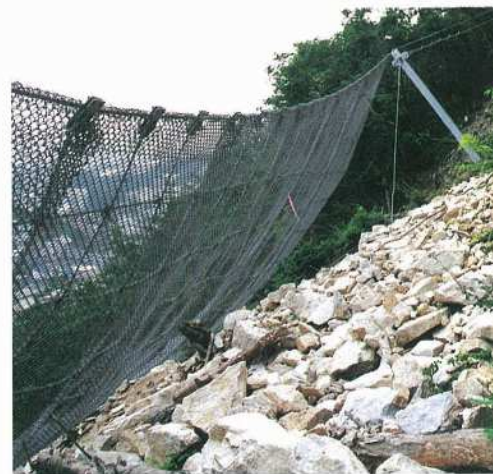
応急工事 仮設防護柵 (H7.3)
