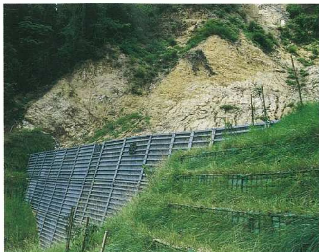
西地区 土留工完了
