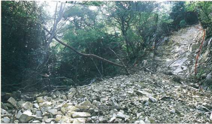
(北崩壊地) 山腹崩壊状況
