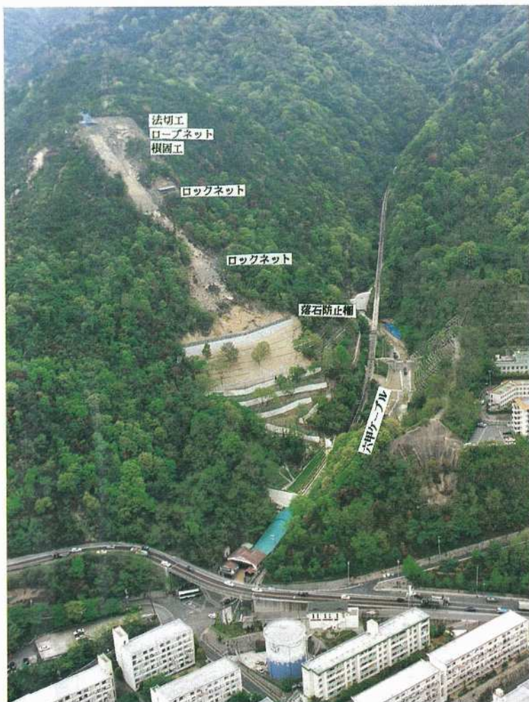
緊急工事完了状況
