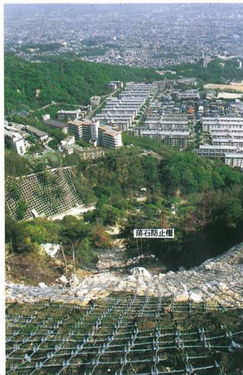
カーテン式ロックネット工
