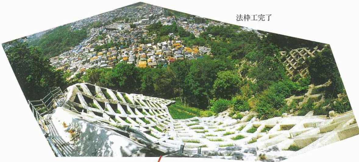
緊急対策完了状況
