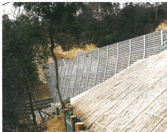
西地区 No.2 谷止工完了
