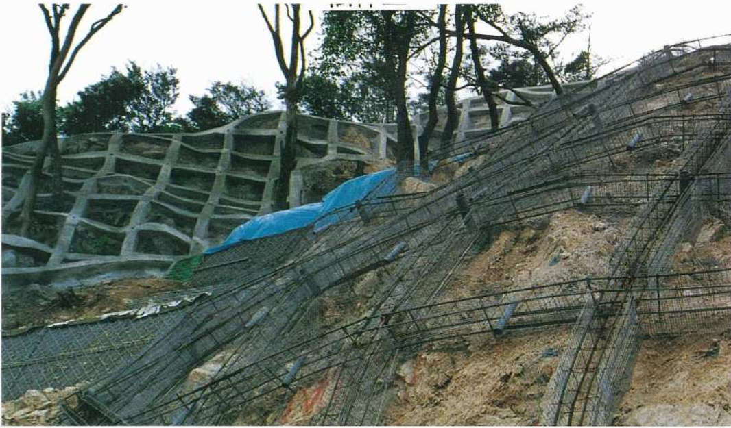
フレーム施行完了
