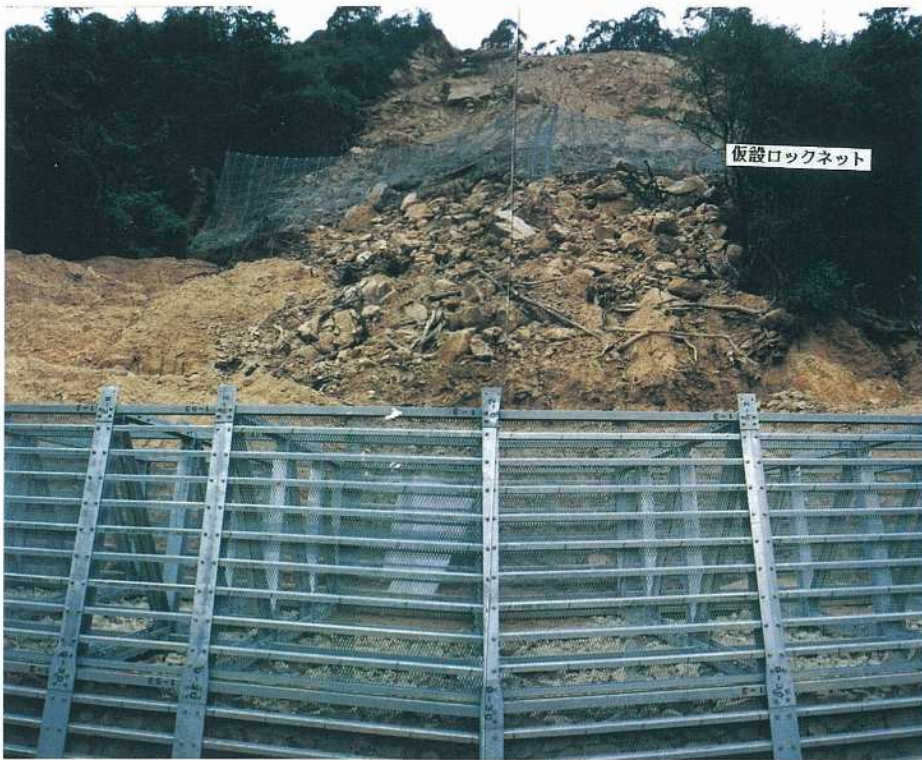
土留工施行中
