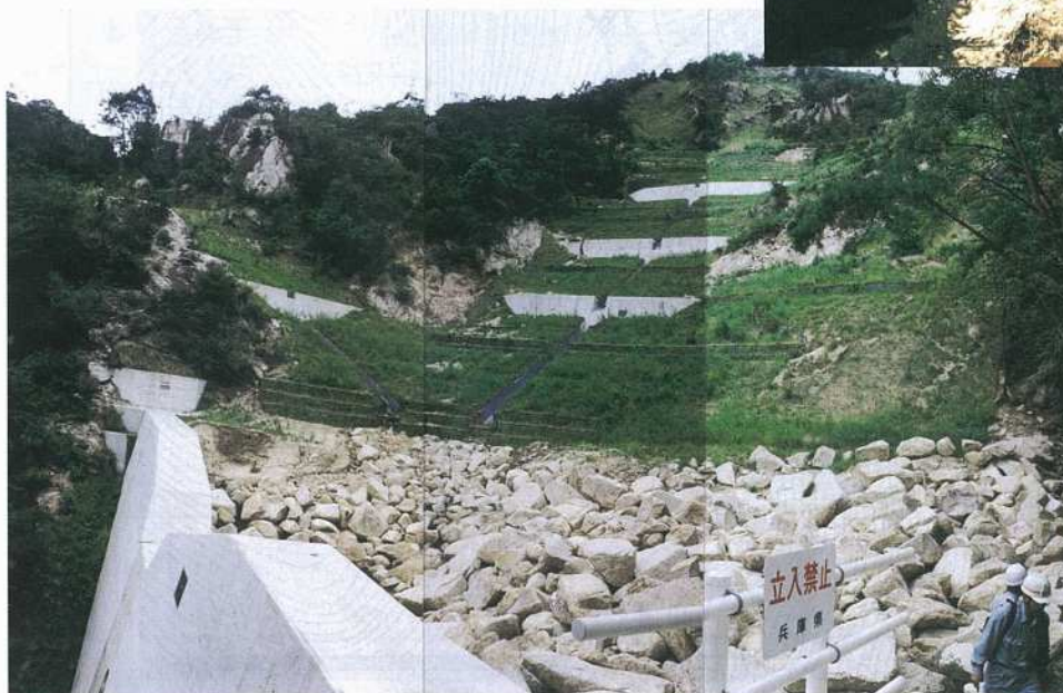
谷止工及び山腹工完了
