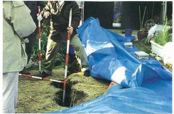
上部住宅地の被害
