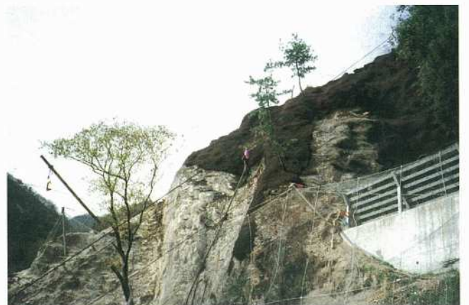
厚層基材の吹付工 施行中
