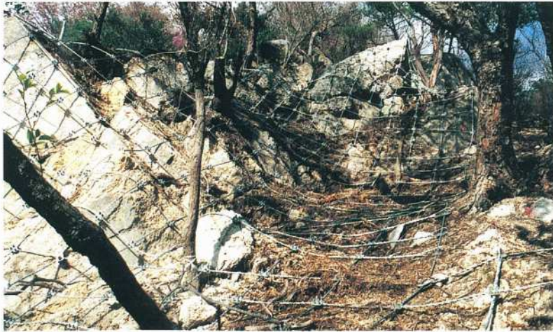
ロープネット工
