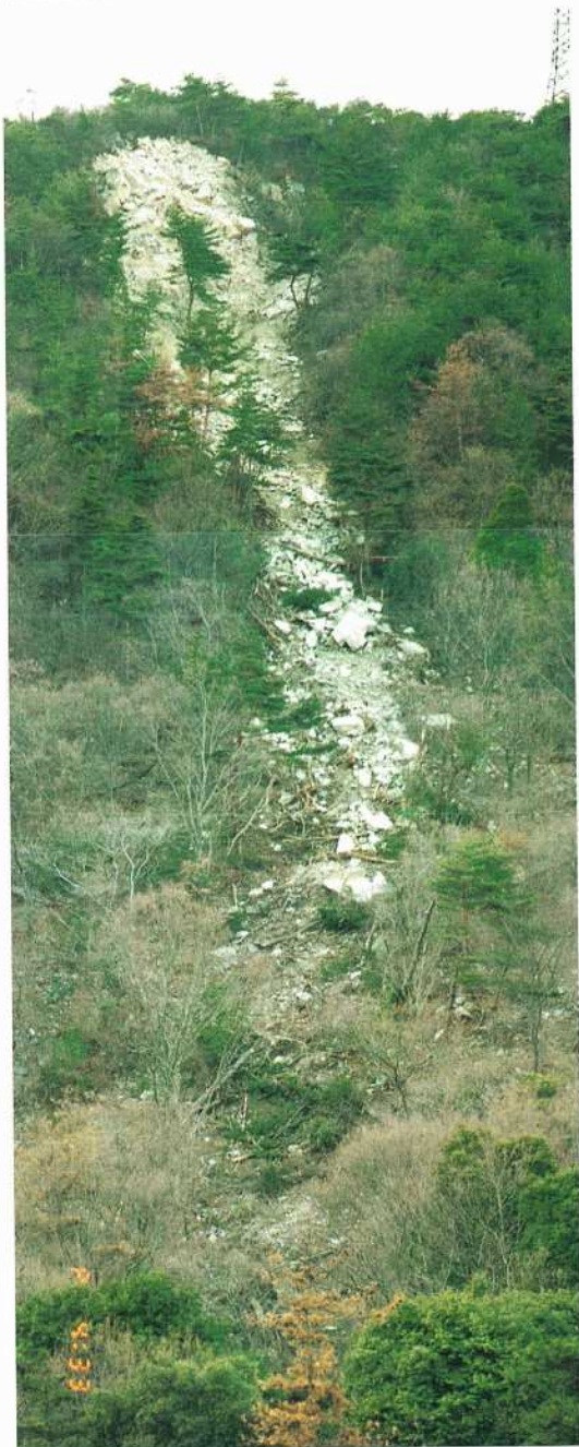
山腹崩壊状況
