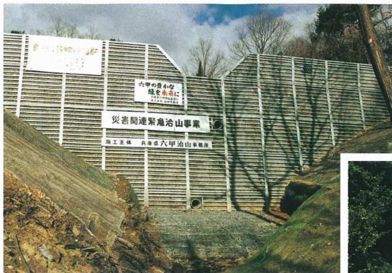
中地区 No.1 谷止工完了
