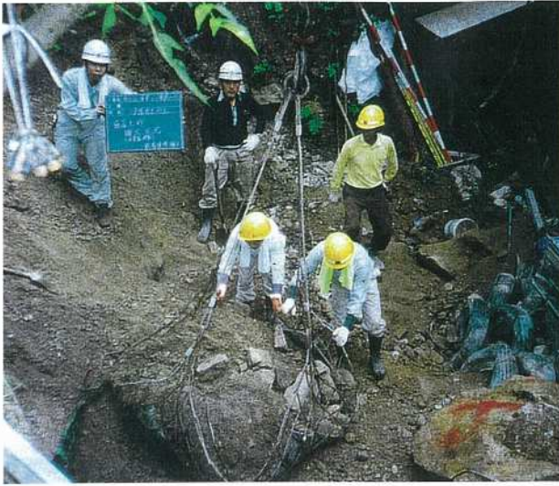
現場外残土処理（索道使用）
