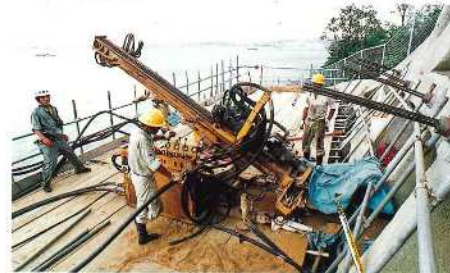
アンカー削孔状況
