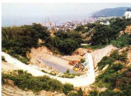
谷止工の施工状況
