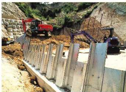
谷止工の基礎部の状況
