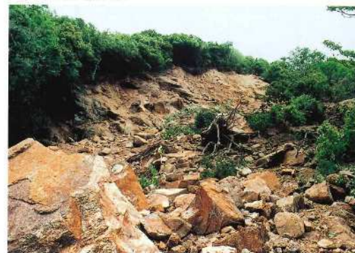
山腹崩壊状況 (施工前)
