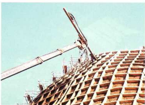
ロックボルトの施工
