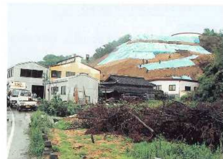
雨天時の法面保護の状況 (平成7年6日撮影)
