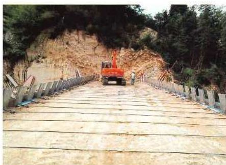
上下流の鋼矢板とタイロッドの状況
