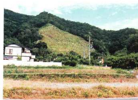
工事完了後の緑化の状況(平成9年10月撮影)
