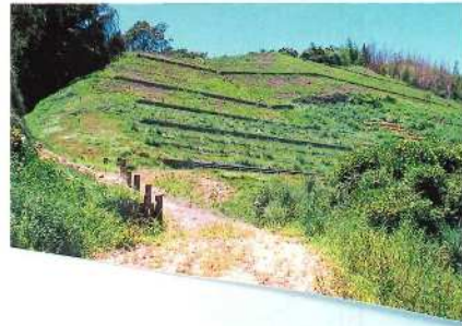
工事完成後3ヶ月の状況
