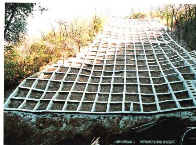
法枠工とアンカー工を併用
