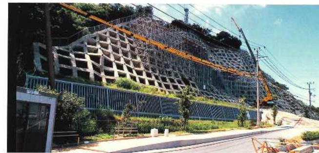
アンカー削孔状況
