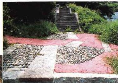
野島断層によってずれた階段
