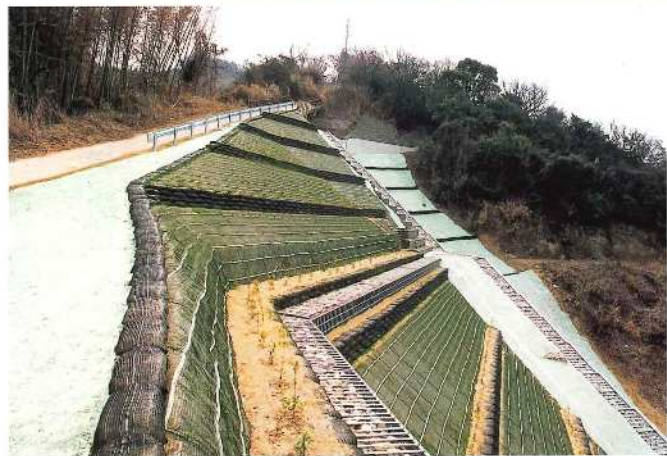
竣工直後の状況
