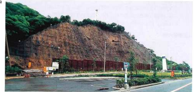
アンカー工施工中
