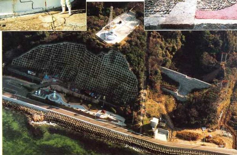
工事施行地全景
