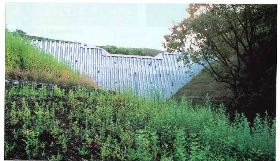
谷止工(鋼製ダブルウォール)の全景(平成9年6月撮影)
