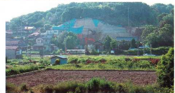
工事施行地全景 (法切工施工中)
