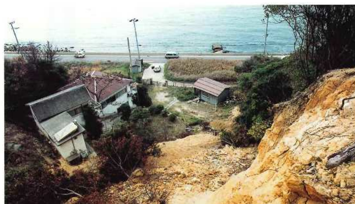
山腹崩壊状況 (保全対象を望む)
