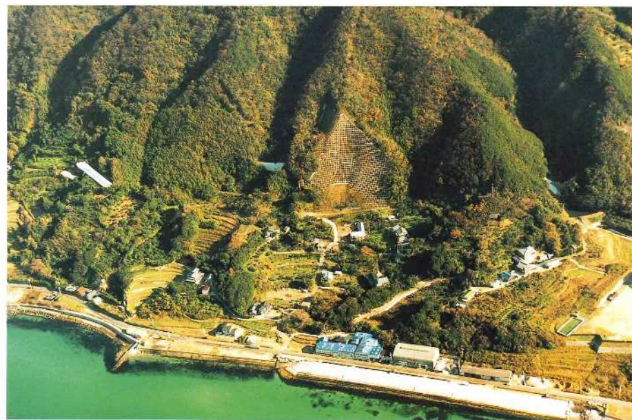
事業地全景(平成9年12月撮影)
