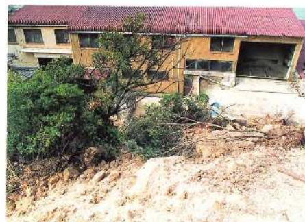
崩壊した土砂と保全対象 (平成7年1月撮影)
