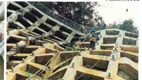
実播工吹付状況
