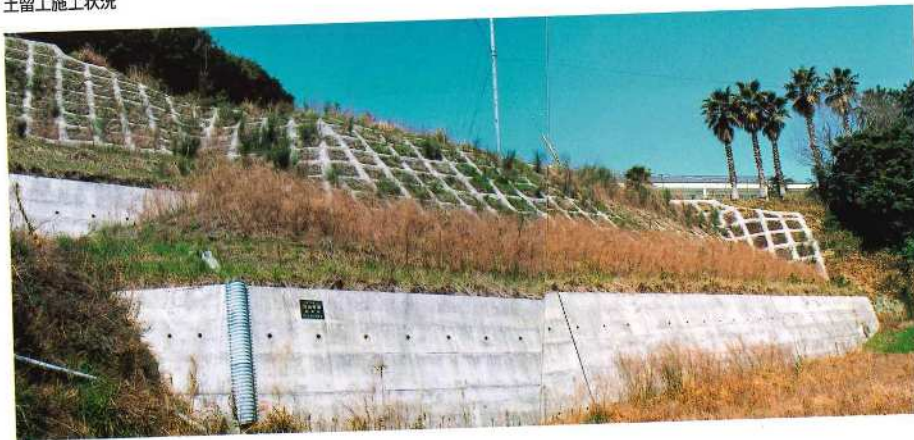
土留工施工状況
