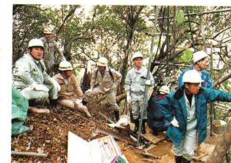
対策工の現地検討
