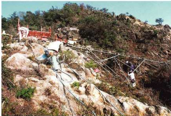
転石の撤去作業状況
