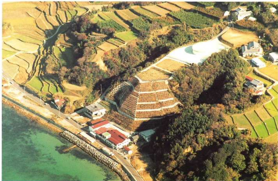
事業地全景 (平成9年12月撮影)
