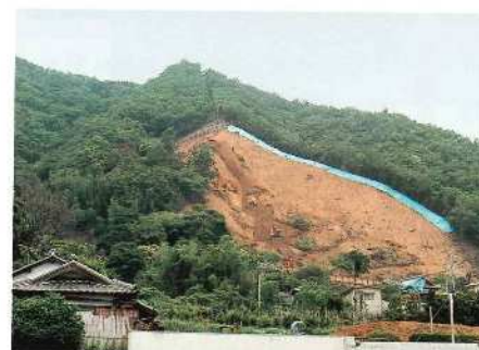
法切工施工状況(平成7年5月撮影)
