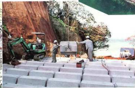
谷止工施工状況
