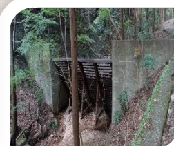
昭和からの治山ダム
