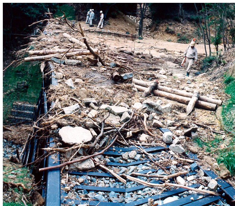
過去に施工していた治山ダムにより土砂を止め被害を最小限に食い止めた。
