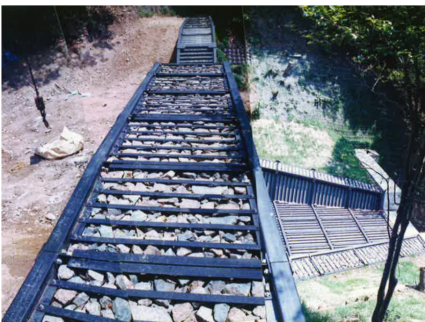
復旧後 平成12年（2000年）4月
