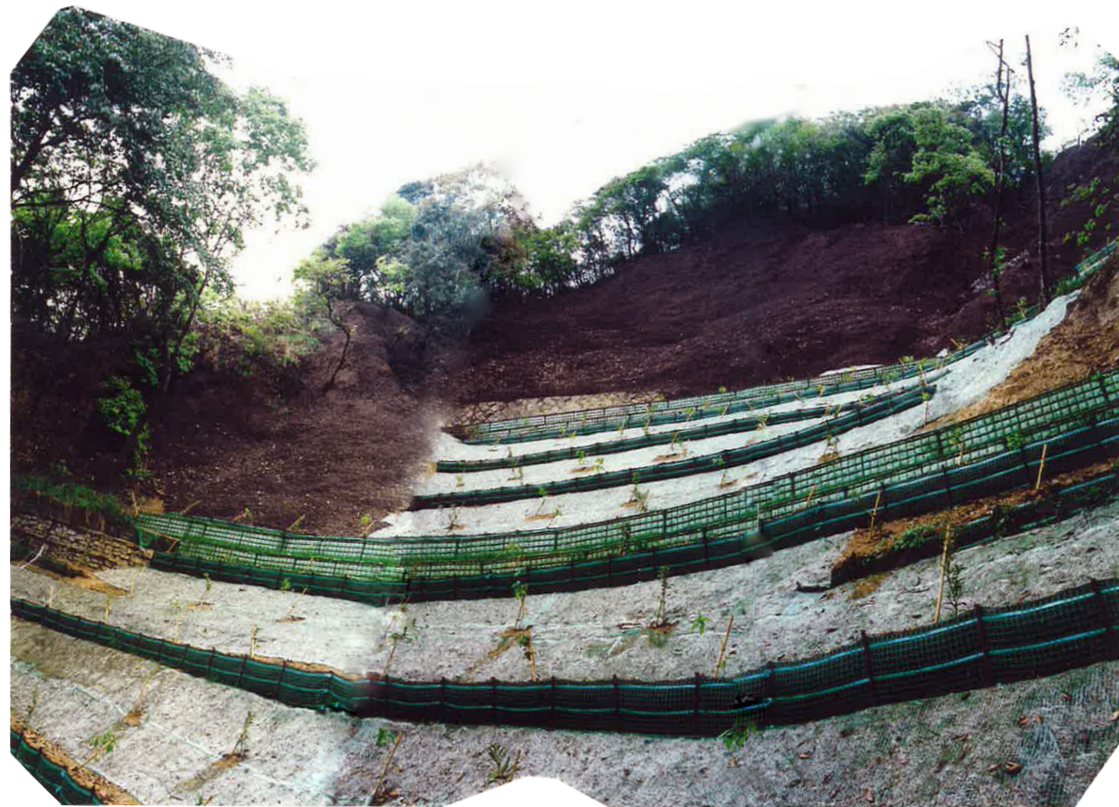
復旧後 平成8年（1996年）4月
