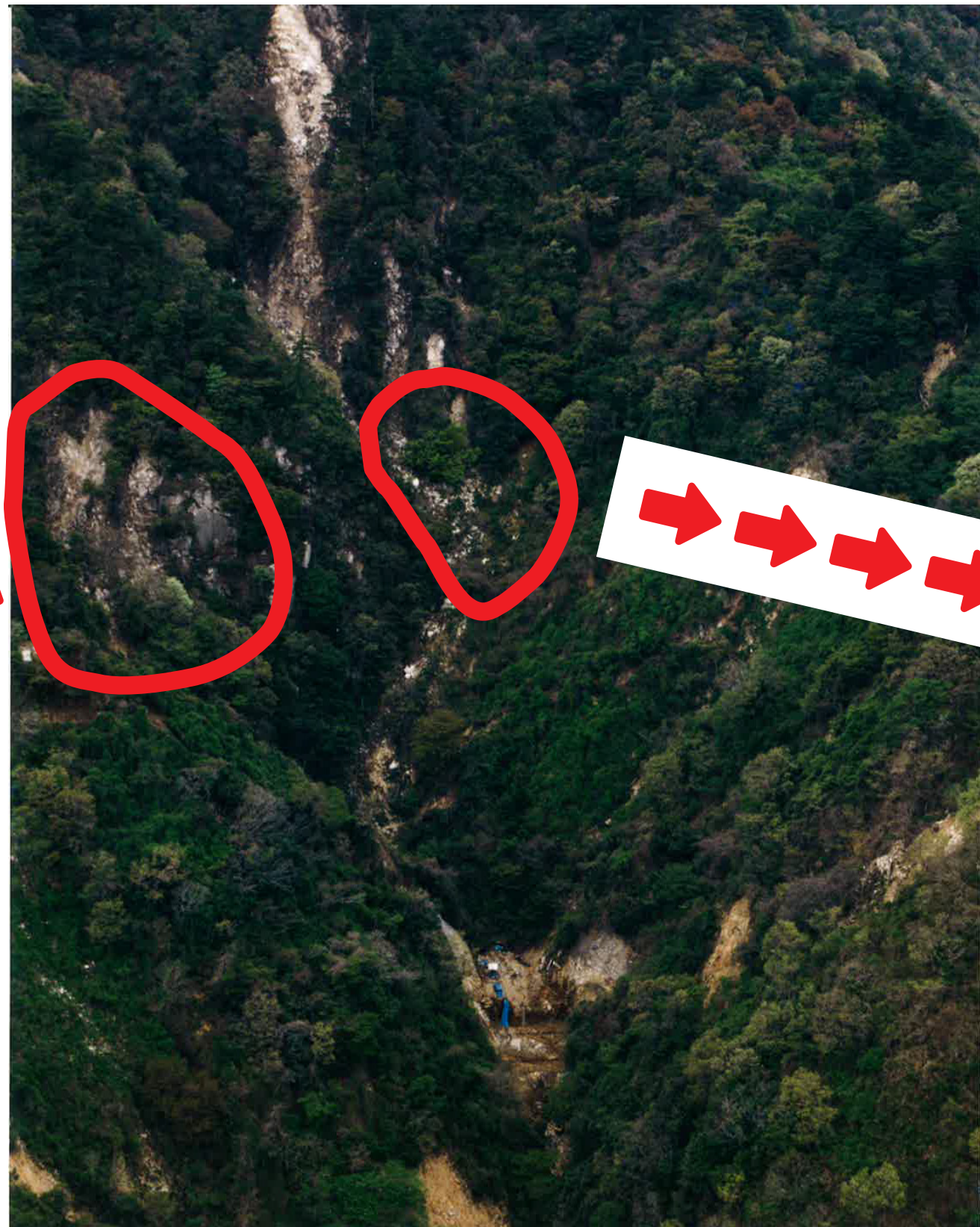
工事施工中 平成8年（1996年）3月
