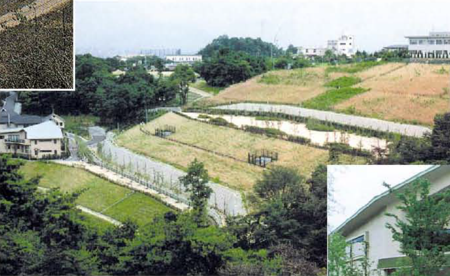
復旧工事の完了した仁川百合野地区。左側のグリーンの建物に斜面の動きを自動監視するシステムを持つ「地すべり資料館」（平成9年7月）
