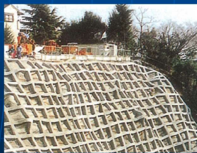
杣谷山腹緊急工事 完成
