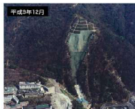
崩壊地の中間部にもマット工によって植物の種子を含む土を吹付け
