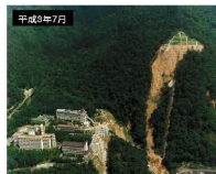
崩壊地最上段にコンクリート格子等を敷いた後に緑化工事
