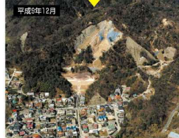
谷の出口に砂防えん堤を建設
