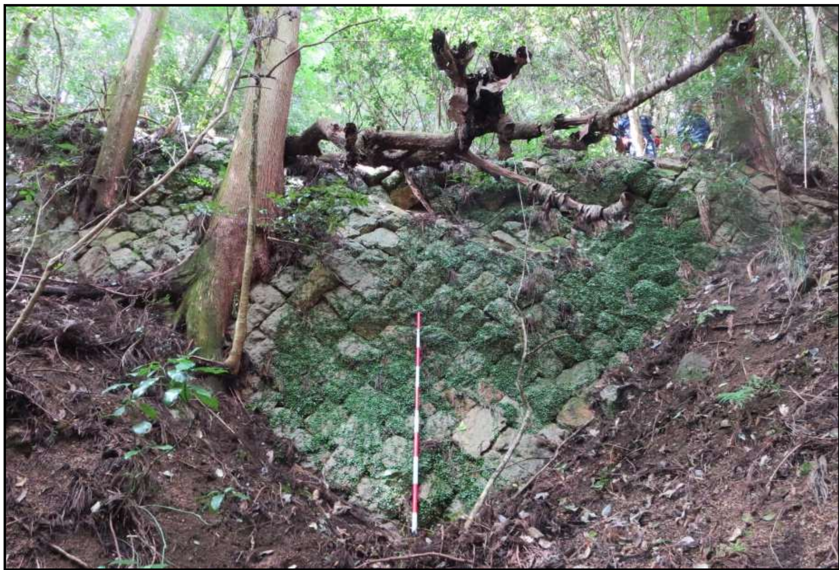
④ 石積土留工（イシズミドメコウ）③の近景 土砂の固定、表土の安定を図っている。 昭和10年前後の施工？ 再度ドライブウエーの工事関連？
