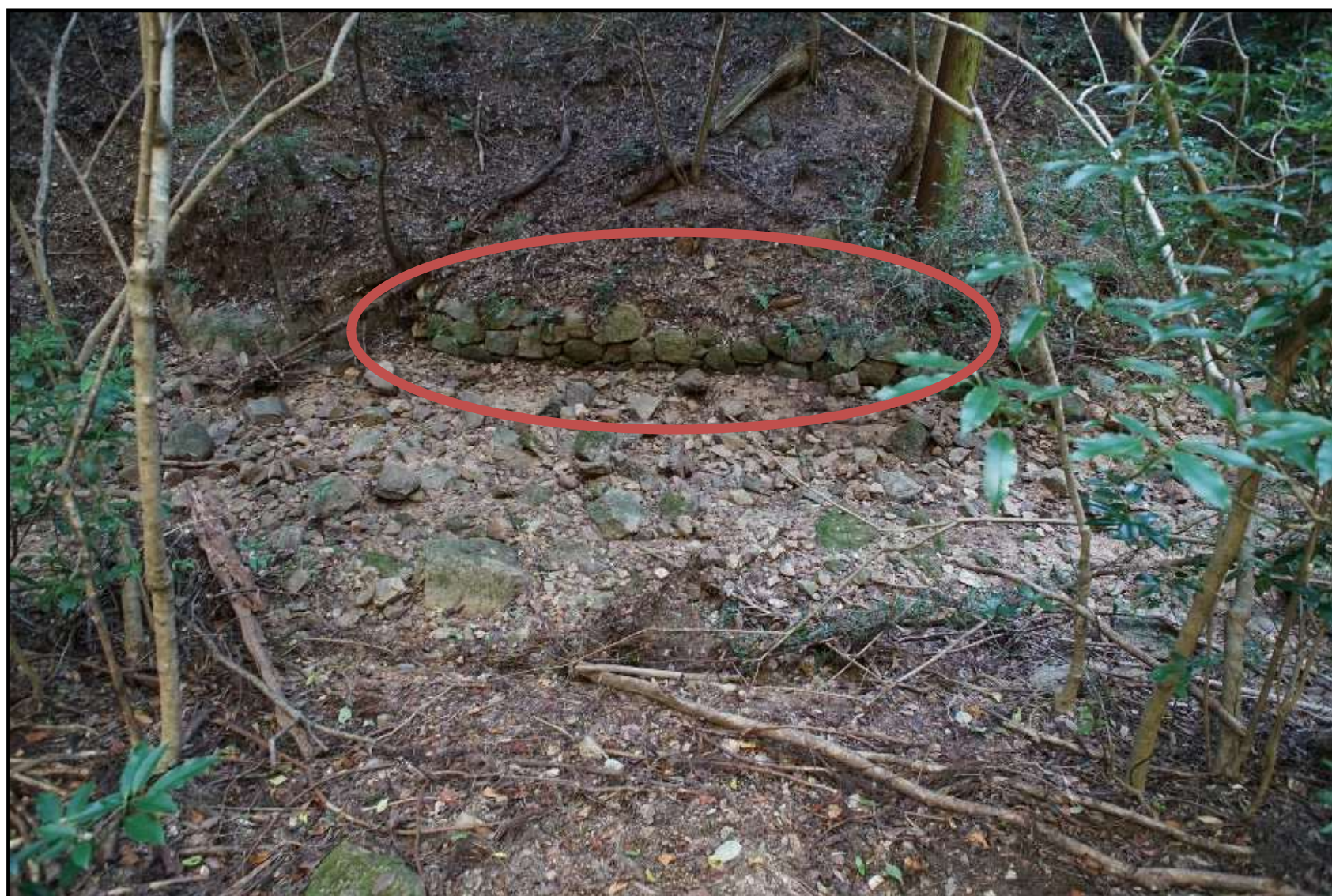
⑤ 石筋工（イシスジコウ） 土砂の流出防止
