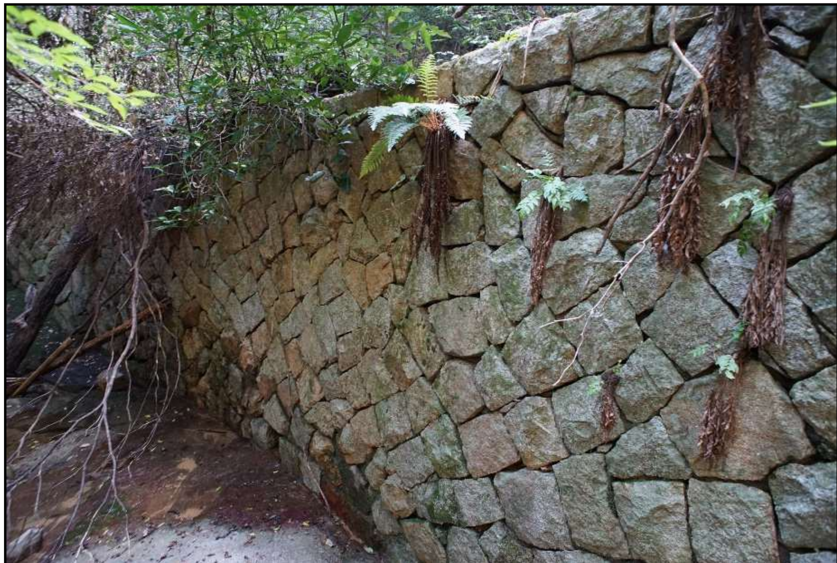
③ 石積堰堤（イシズミエンテイ）近景 下流右岸の状況 明治30年代の遺構
