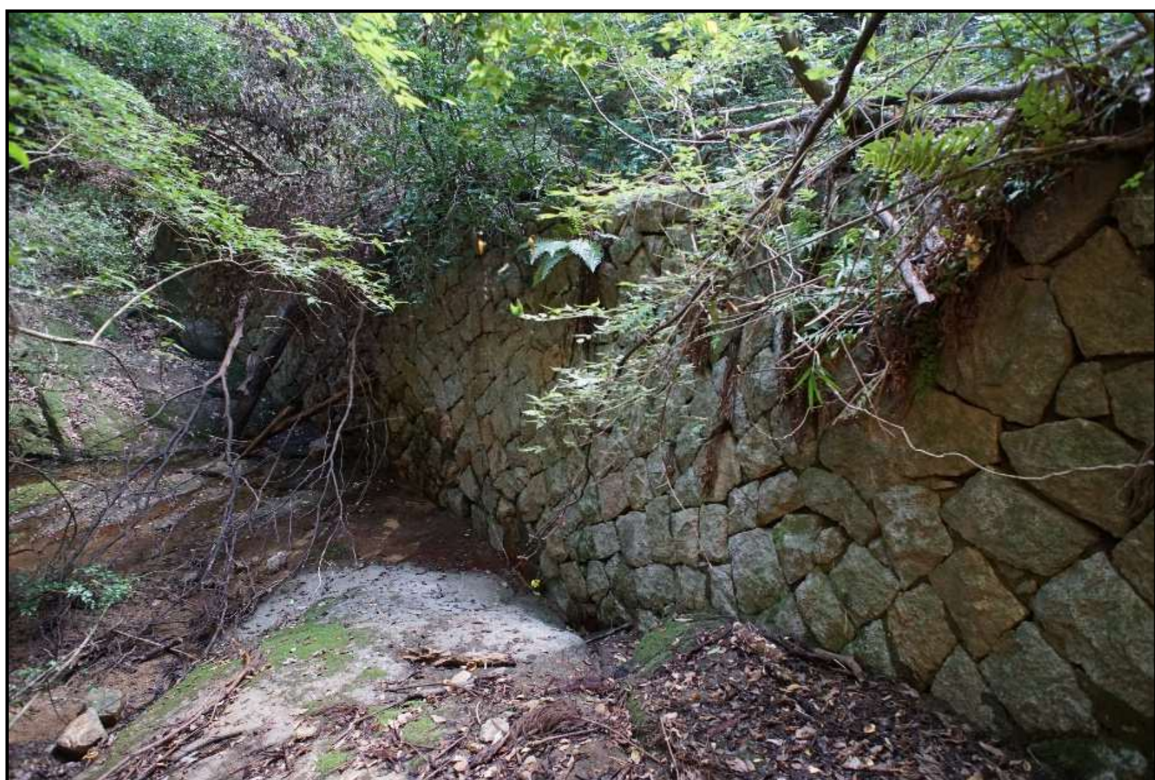
④ 石積堰堤（イシズミエンテイ）近景 下流左岸の状況 明治30年代の遺構
