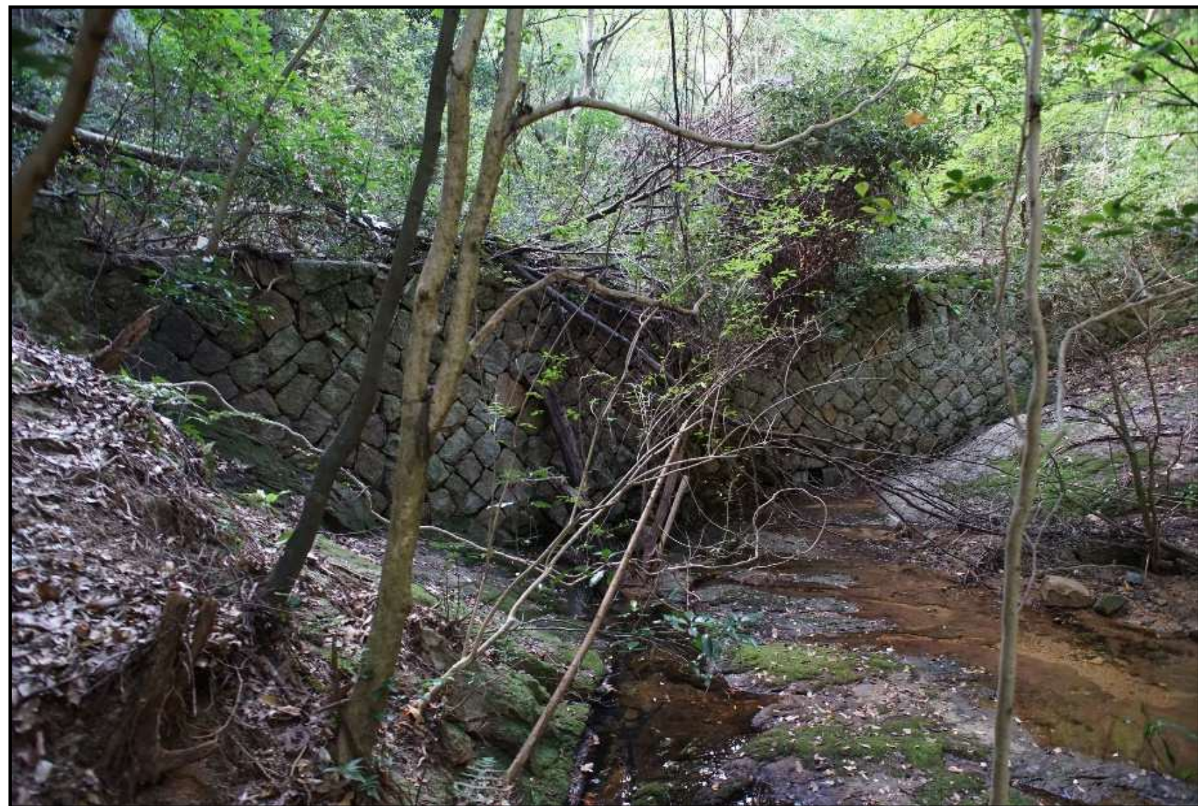
① 石積堰堤（イシズミエンテイ） 下流正面から 明治30年代の遺構
