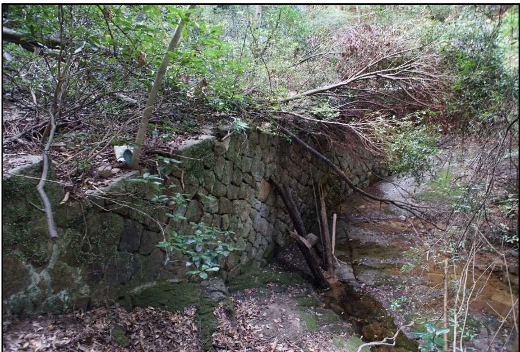
② 石積堰堤（イシズミエンテイ） 下流の左岸側から右岸側を望む 明治30年代の遺構
