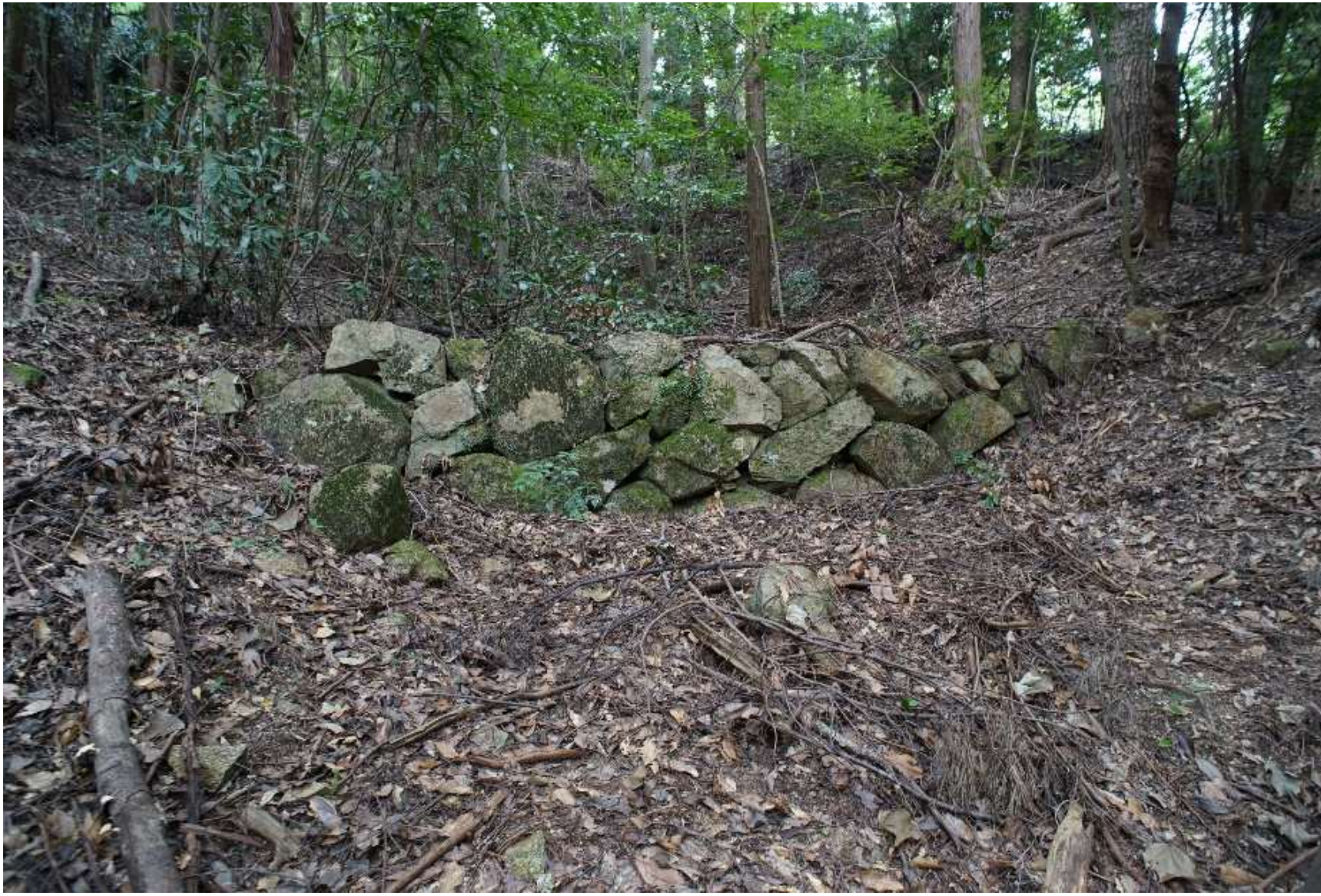
② 石筋工（イシスジコウ）①近景 土砂の流出防止 緑化の基礎（植木鉢）
