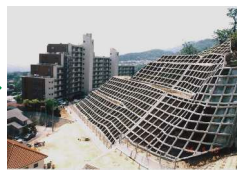
工事完成直後
