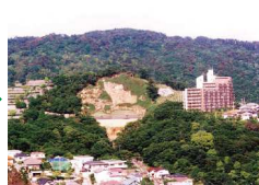
工事完成直後
