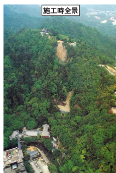
工事着手時 平成7年（1995年）
