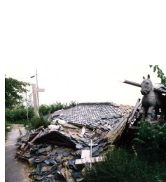
家屋全壊状況
