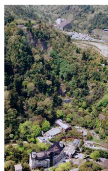
復旧状況 平成12年（2000年）5月
