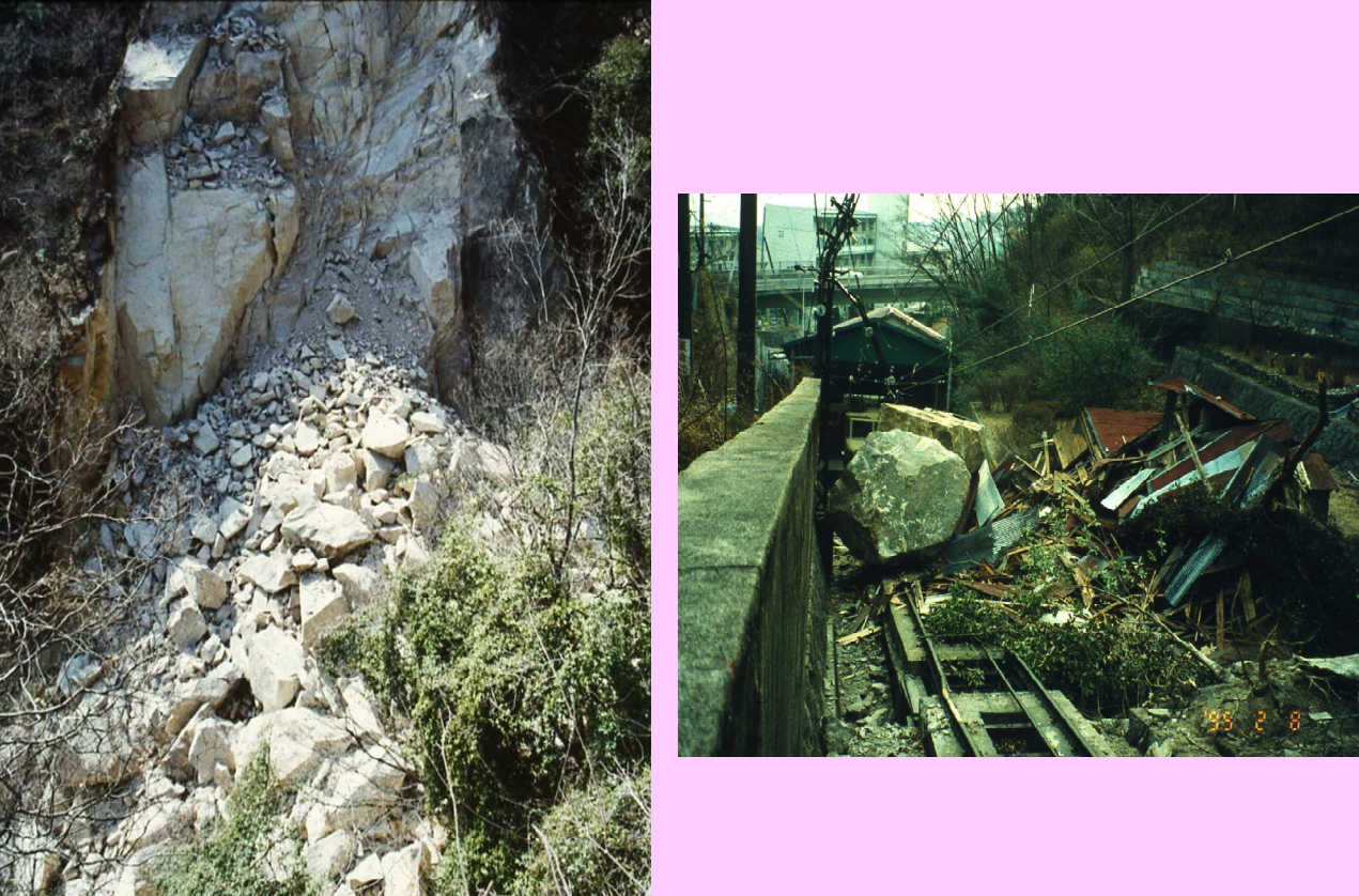
芦屋川水系の山くずれ 六甲ケーブル土橋駅の落石
