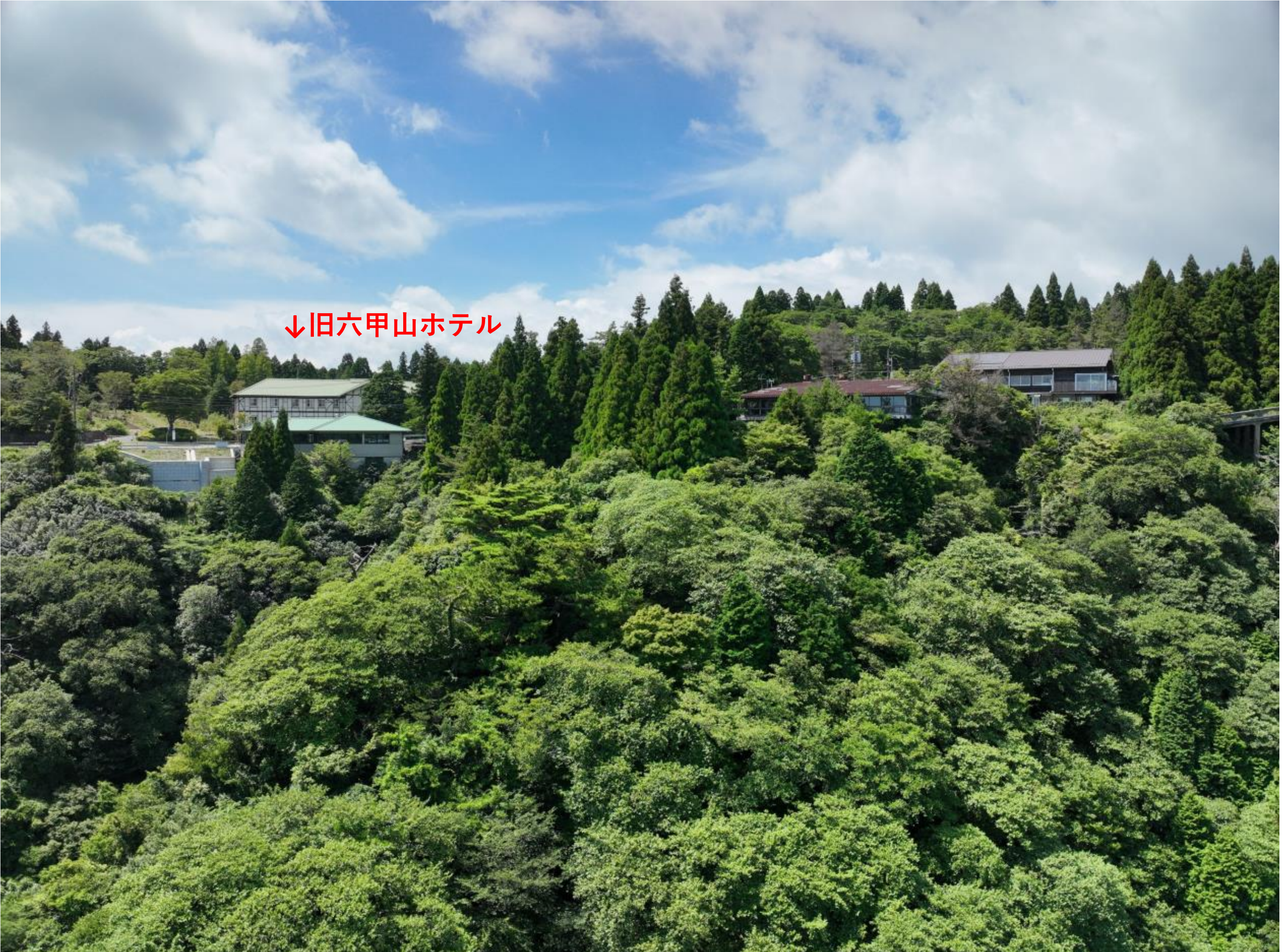
工事後85年経過の現況【令和7年（2025年）7月撮影】
