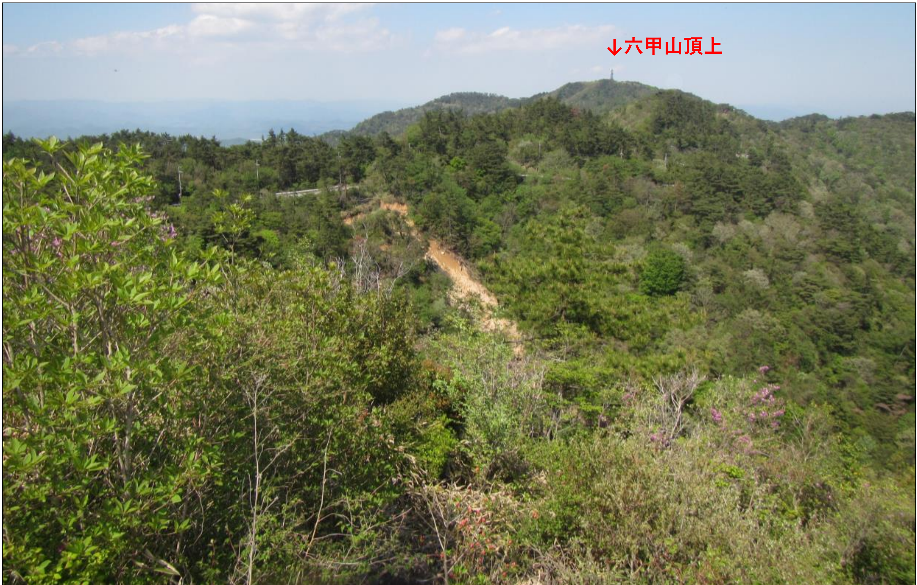
平成30年（2018年）7月豪雨で崩壊が発生、現在、復旧工事を実施中 工事後60年経過の現況【令和2年（2020年）5月撮影】
