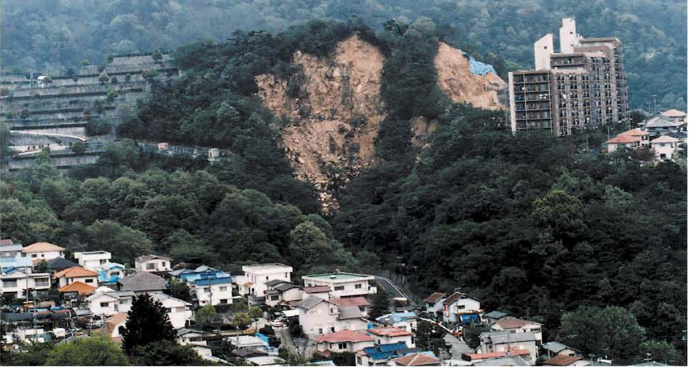
住吉台の山腹崩壊
