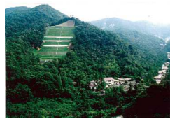
工事完成直後 平成9年（1997年）
